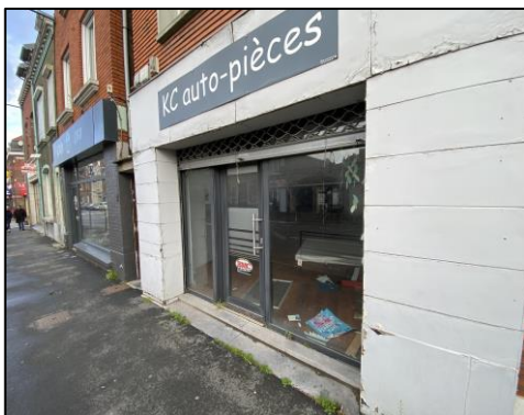
Vacant depuis 2019 – rue du Général de Gaulle
