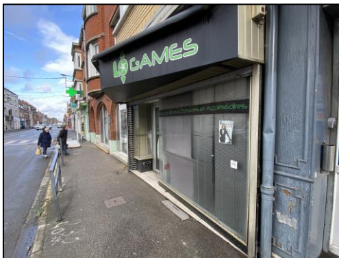
Vacant depuis 2014 - rue du Général de Gaulle
