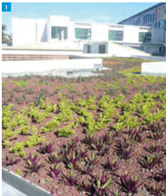
1. Toiture végétalisée sur un hôpital, Le Tampon
