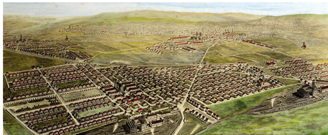
Vue d'ensemble des fosses n°11, 16, 3 et 9 de la Société des mines de Lens vers 1920 © Centre historique minier Lewarde
