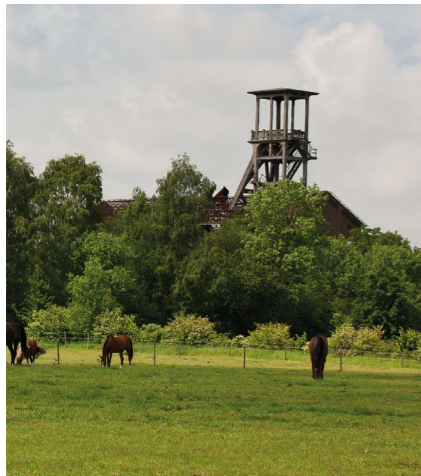
Chevalement de la fosse n°2 à Anhiers © Hubert Bouvet - Région Hauts-de-France
