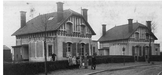
La cité-jardin Bruno construite en 1904 par la Société des mines de Dourges © Centre historique minier Lewarde
