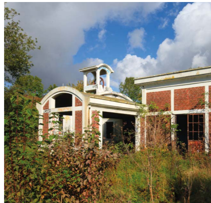
Chevalement de fosse n°13 bis à Bénifontaine © Hubert Bouvet - Région Hauts-de-France
