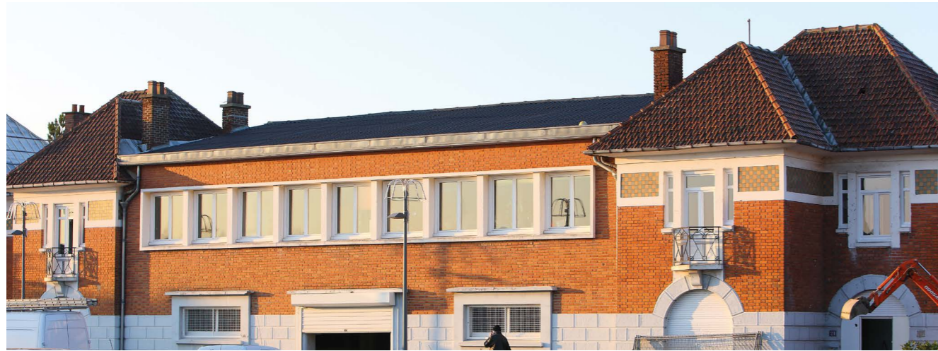
Dispensaire de Société de Secours Minière à Grenay © Samuel Dhote - Mission Bassin Minier
