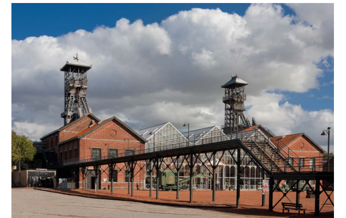
Chevalements de la fosse Delloye à Lewarde © Hubert Bouvet - Région Hauts-de-France
