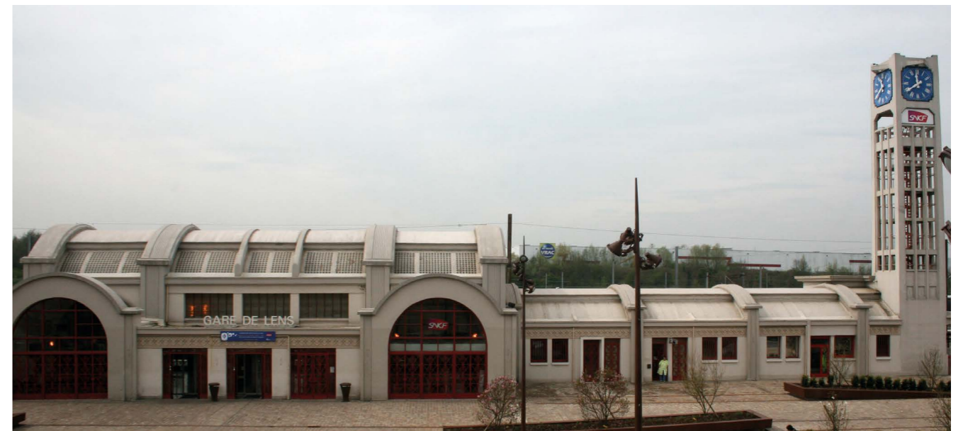
La gare de Lens, en forme de locomotive (1927, Architecte Urbain Cassan) © SRMH 2009
