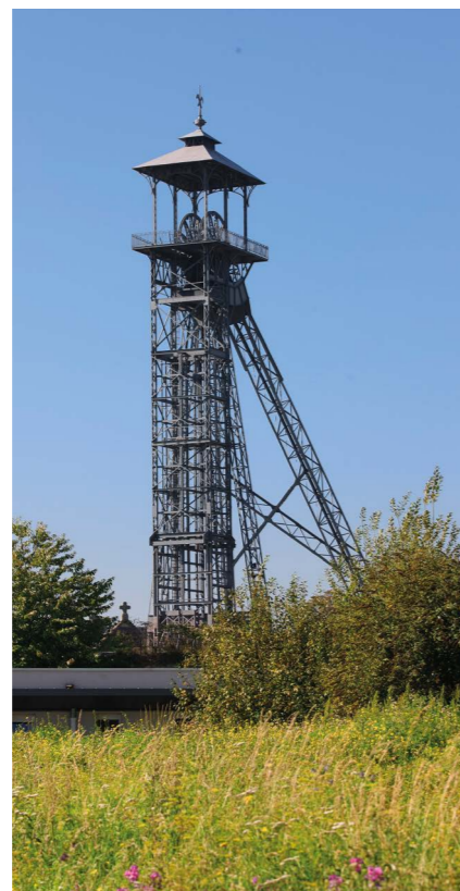
Chevalement du n°3bis de la Société des Mines de Lens à Liévin © Hubert Bouvet - Région Hauts-de-France
