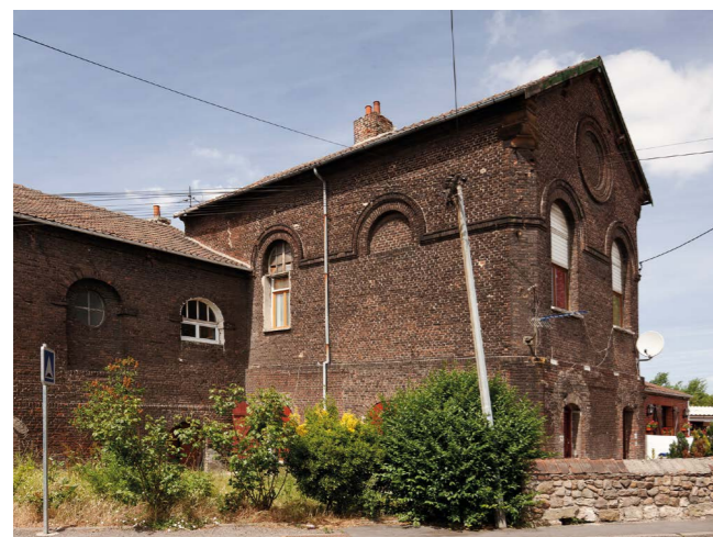
La fosse Mathilde à Denain, modifiée en 1854 puis transformée en logements par la Compagnie des mines d'Anzin en 1963 © Hubert Bouvet - Région Hauts-de-France
