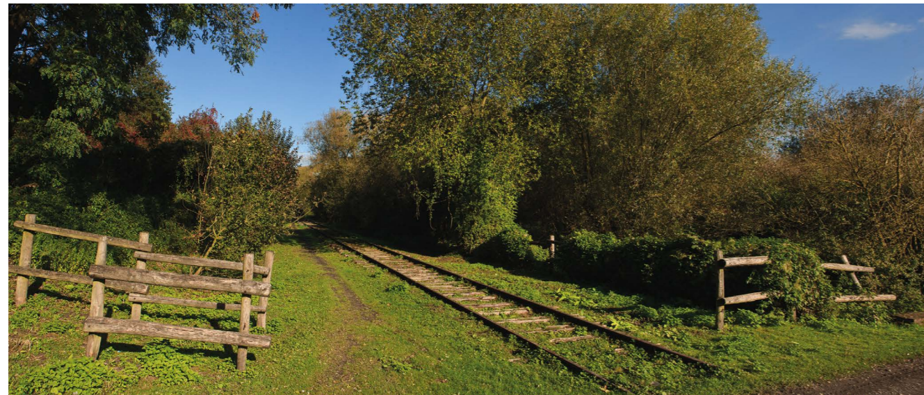
Tronçon de cavalier à Haveluy © Hubert Bouvet - Région Hauts-de-France
