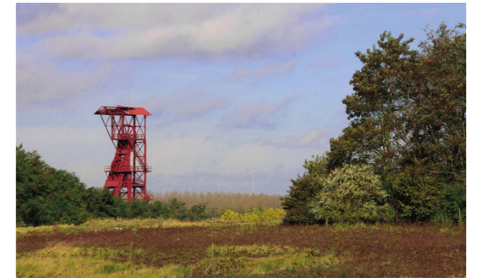
Chevalement de la fosse n°8 à Evin-Malmaison © Hubert Bouvet - Région Hauts-de-France
