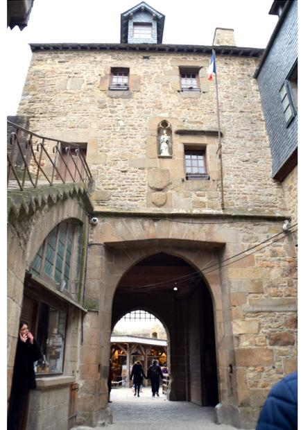
Bati en grés multicolore et granit blond, le bâtiment ne semble pas avoir connu de dégradations liées au temps ni à l'air salin. Sa couverture et ses maçonneries présentent un très bon état de conservation. Cependant les joints de façades ont été réalisés en grande partie avec du ciment bloquant la capillarité des murs. Les menuiseries extérieures sont en bois simple vitrage
