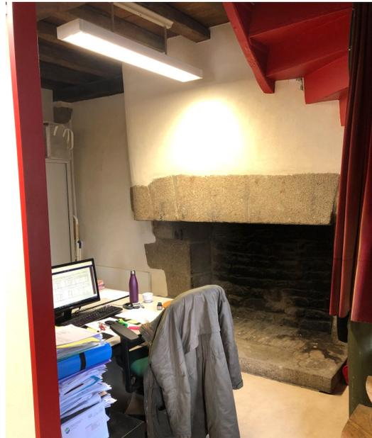
Les murs périphériques ne bénéficient d'aucune isolation et le confort thermique hivernal ne peut être obtenu que grâce à une dépense en énergie très importante à l'aide des panneaux rayonnants électriques, eux-mêmes limités dans leur efficacité en raison du mobilier réparti dans les espaces.
