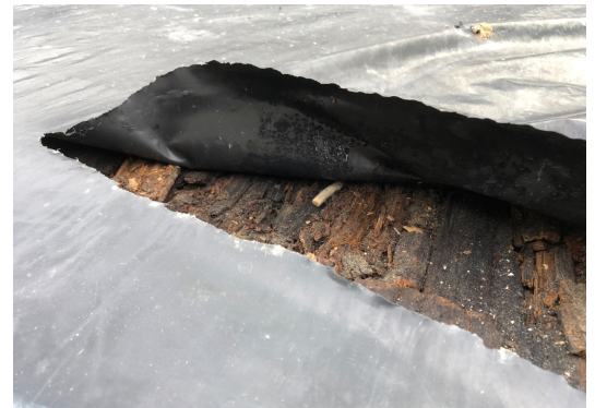
La pose d'une bâche plastique étanche a certainement accéléré la dégradation des bardeaux par un effet de condensation important.
