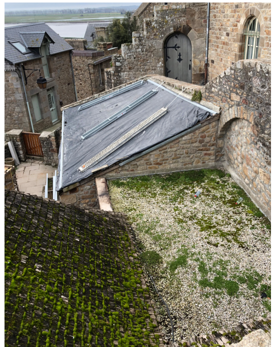
La pose d'une bâche plastique étanche a certainement accéléré la dégradation des bardeaux par un effet de condensation important.
