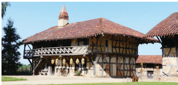
Bâtiment principal historique avant réhabilitation - © Grand Bourg Agglomération
