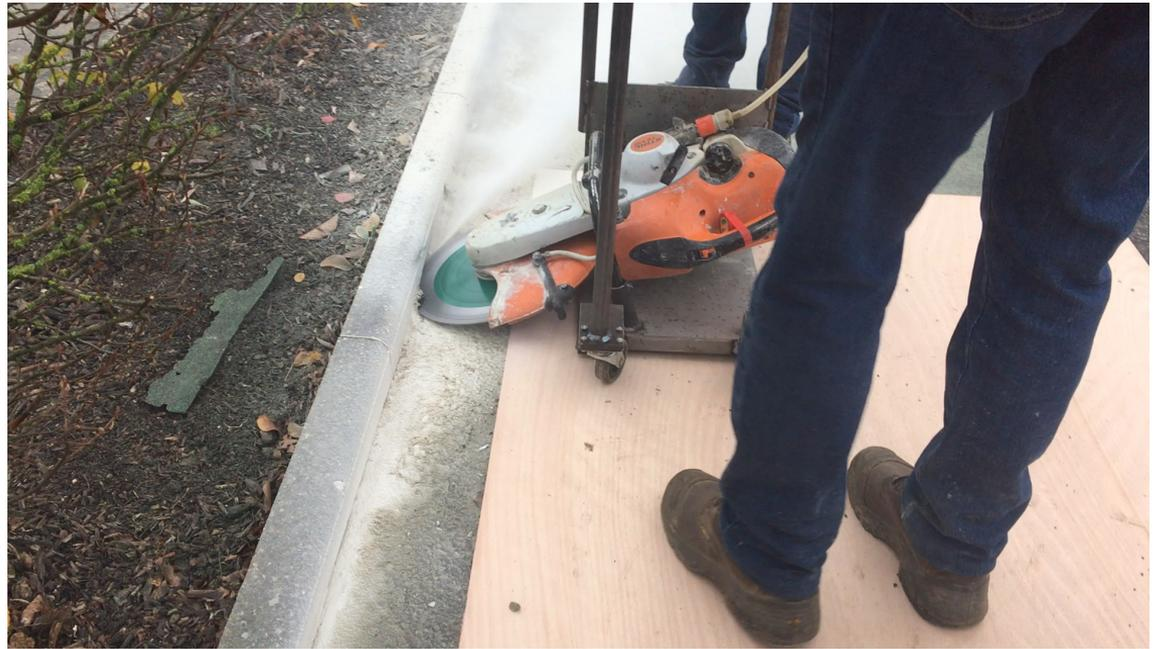
A l'aide d'une scie sur un châssis adapté, l'arasement des bordures est aisé et permettra l'infiltration de l'eau du trottoir dans les espaces verts.
