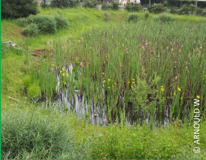
**Zones** pouvant être utilisées pour stocker les eaux de ruissellement de toitures ou voiries en assurant une **fonction de rétention**.
