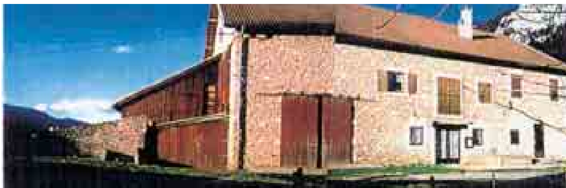
Une construction en pierre brute - sauf pour les chaînes d'angles et les encadrements d'ouverture en pierre de taille plus ou moins grossière
