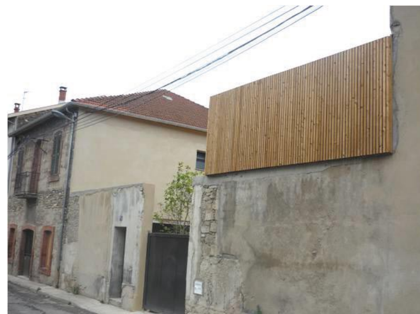
Cette extension située à Romans sur Isère s'appuie sur un mur ancien qui limite la rue et se glisse entre deux maisons dans la cour.
