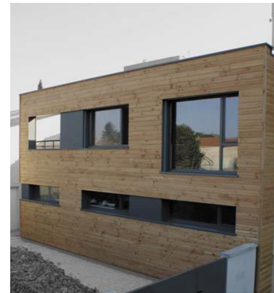
A Romans sur Isère, l'extension des bâtiments des Douanes offre des locaux lumineux et s'inscrit sobrement en continuité du bâtiment existant. Architecte C. Lapourielle
