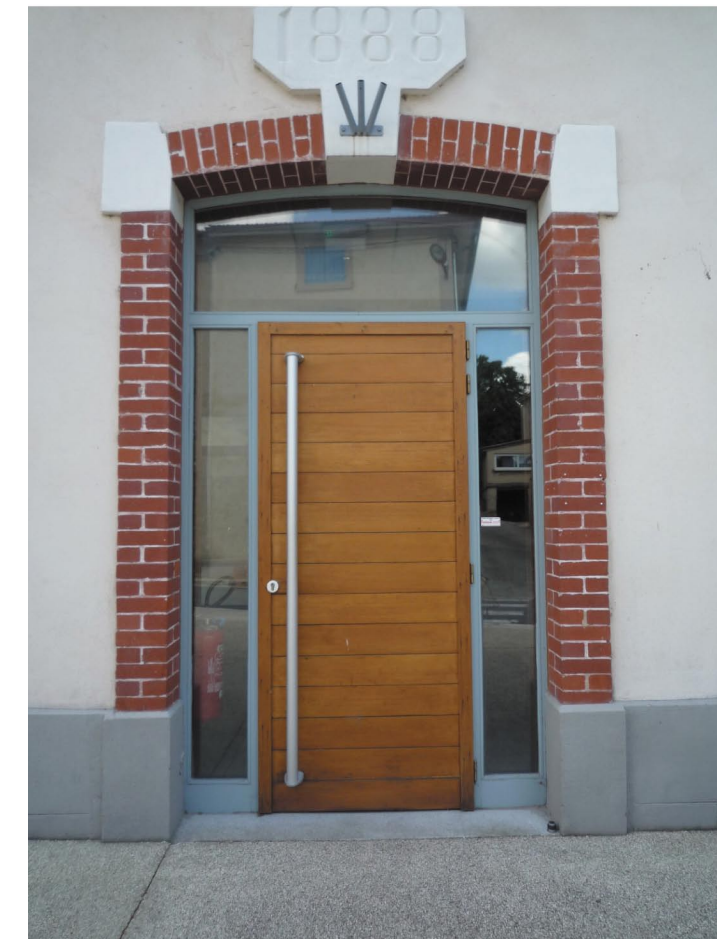
Une porte contemporaine dans un encadrement ancien. Mairie de Mours-Saint-Eusèbe Architecte : P.Abeille et B.Cogne
