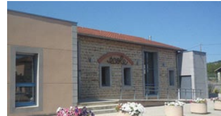
L'école de Saint Michel-sur-Savasse réinterprète les murs de galets de la tradition locale. (Architecte Ph. Amette).
