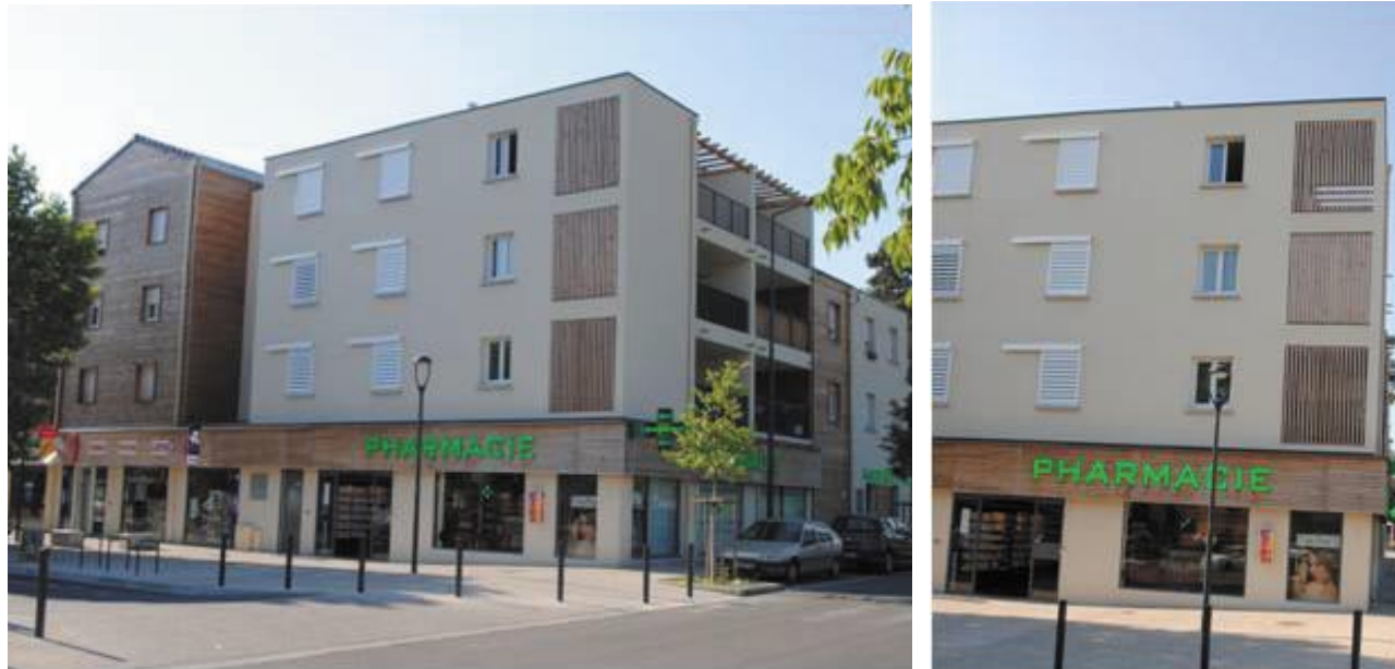
A Romans sur Isère, les commerces aménagés en rez de chaussée de logements locatifs, valorisent l'image du quartier. Maître d'Ouvrage OPH, Architecte L.Boulant.
