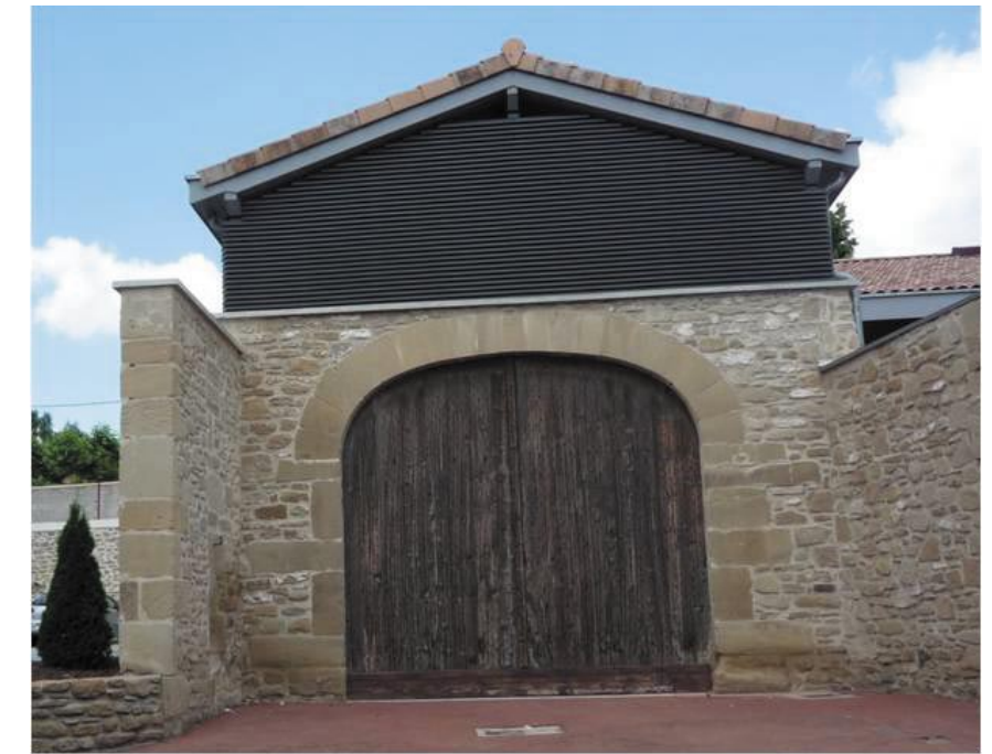
Surélévation avec pignons en bardage à claire-voie Maison des associations à Mours Saint Eusèbe. Architectes P.Abeille et B.Cogne
