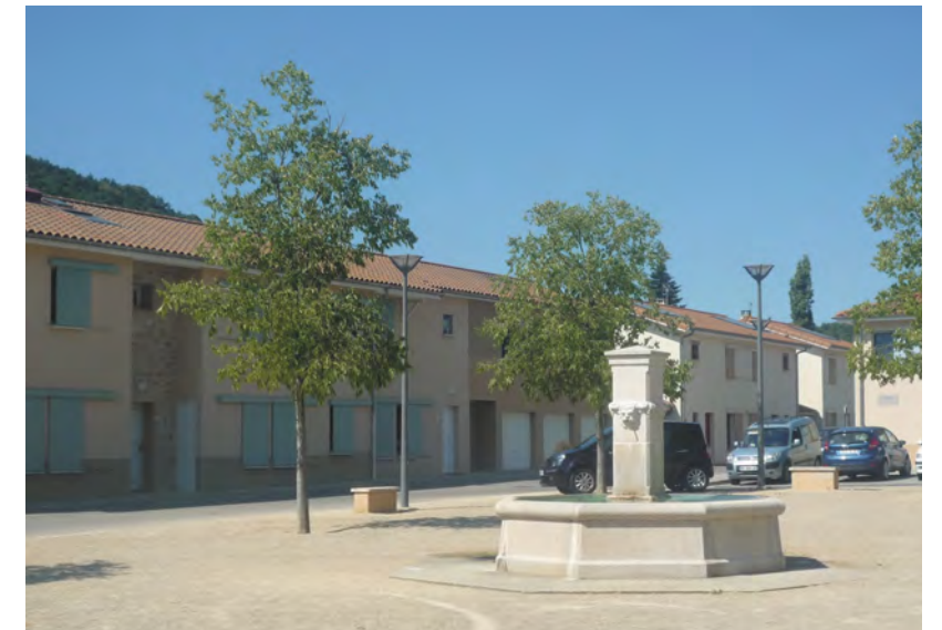
Réalisation de logements neufs et aménagement de la place du village de Triors.
