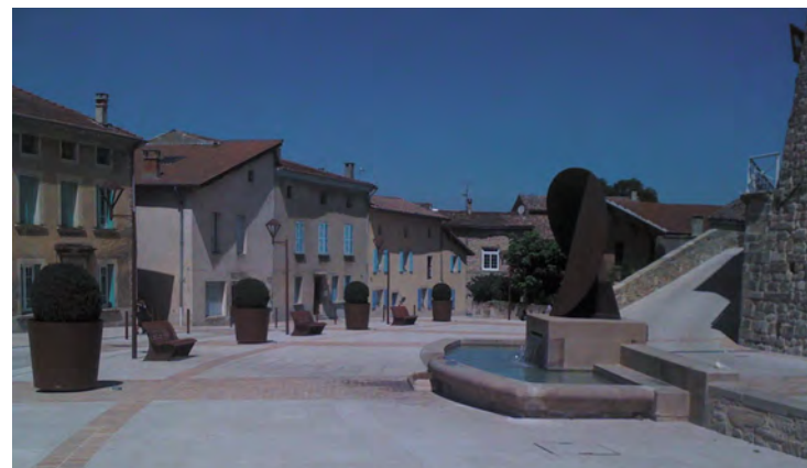
La route est pensée comme une rue, avec ses revêtements, sans différence de niveau avec le trottoir, un accompagnement végétal.....Alixan (Architectes E. et C. Colomb).
