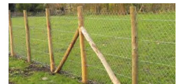
Poteaux bois et grillage à poule
