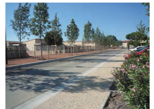
Création de trottoirs et plantations de part et d'autre de la voirie. Grange-les-Beaumont, (Paysagiste: G. Cordeil).
