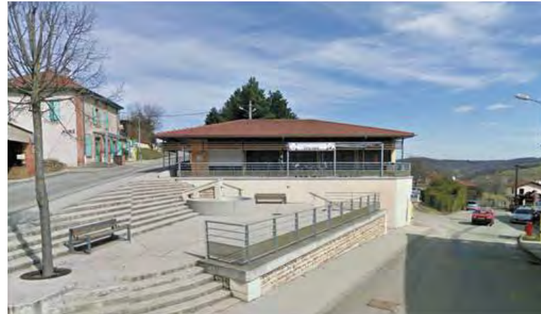
Construction d'un restaurant et aménagement d'une place à Montrigaud.
