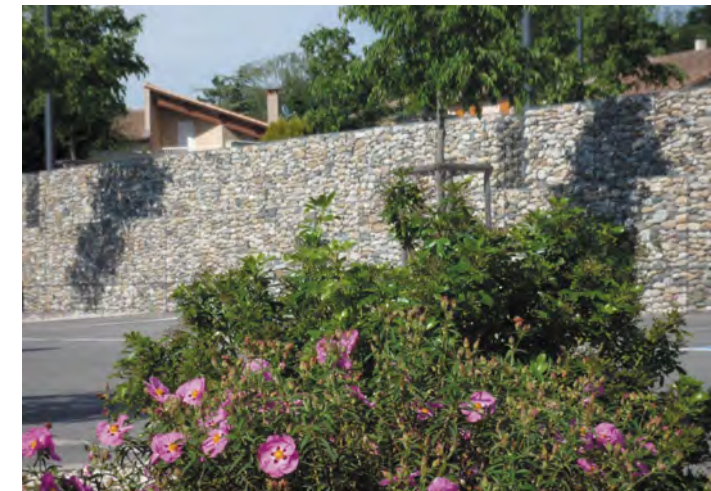
Le parking est planté et le mur de soutènement est en pierre. Etoile-sur-Rhône.
