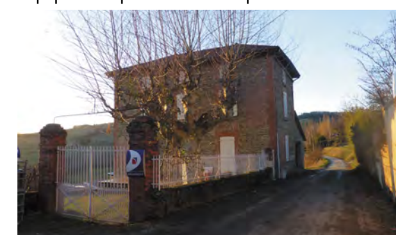
Serrurerie traditionnelle sur muret à Geysans
