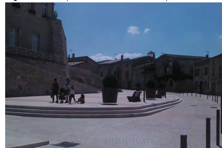
L'emmarchement met en valeur le bâti. Alixan (Architectes E. et C. Colomb).
