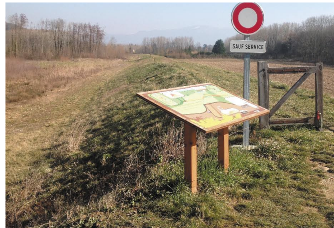
Digue de la Savasse. Source CAPR.
