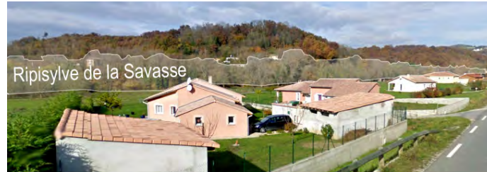
Quartier des Fayolles vu depuis la D52
