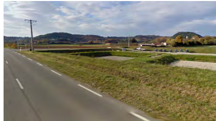
STEP à l'entrée du village
