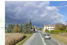
Vue sur le clocher depuis la RD538.
