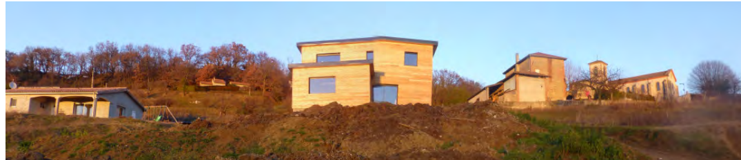
Constructions hétéroclites en aval du village
