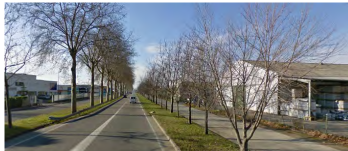
ZA ouest, double terre-plein planté et double contre-allée
