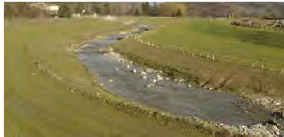
Méandre du lit de la savasse reconstitué en aval du pont de la RD538 à Romans - BET Hydretudes.
