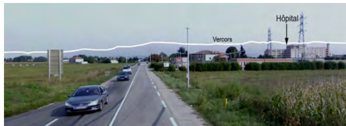
Entrée ouest de Romans par la route de Tain
