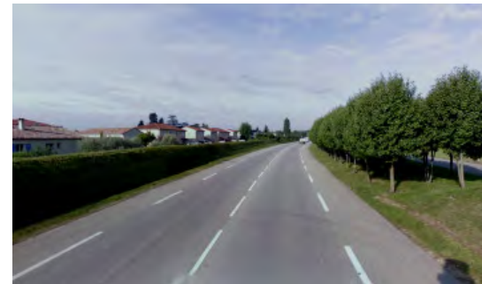
Limite nord de Romans_Boulevard Pierre Mendès France
