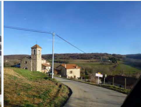
Arrivée dans le village depuis le nord
