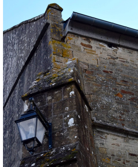
Surmont maçonné façade Ouest
