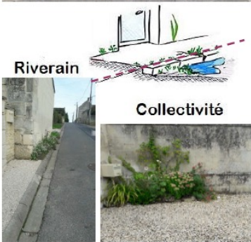
Quelques exemples d'aménagements de trottoirs entretenus par les riverains
