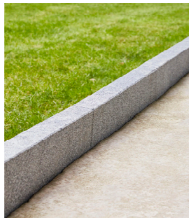
bordures continues (phénomène de canalisation des eaux de ruissellement empêchant toute infiltration dans les accotements)
