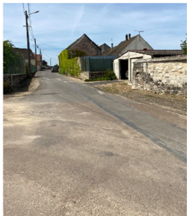
enrobé imperméable (surfaces sombres restituant une chaleur conséquente en période estivale)
