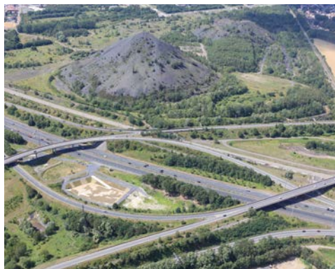
Vue aérienne vers le sud-ouest, depuis Dourges. Au premier plan, les infrastructures routières et voies ferrées, au centre le terril 87 et en arrière, le terril 92. En arrière-plan, la commune d'Hénin-Beaumont. © DREAL HdF 2020 – Ph. Frutier
