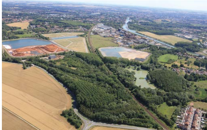
Vue aérienne vers le sud-est depuis Roost-Warendin. À droite de la voie ferrée, le terril et son plan d'eau d'où part vers le canal de la Scarpe, un alignement d'arbres correspondant à l'ancienne voie ferrée longeant le terril. Au deuxième plan, les anciens bassins de décantations de l'usine UMICORE/ Nyrstar. © DREAL HdF 2020 – Ph. Frutier
