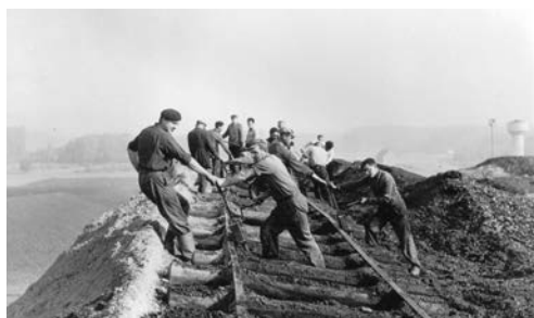
Les ouvriers déplacent la voie ferrée servant au dépôt des matériaux sur les terrils @ Collection Jean-Marie Minot
