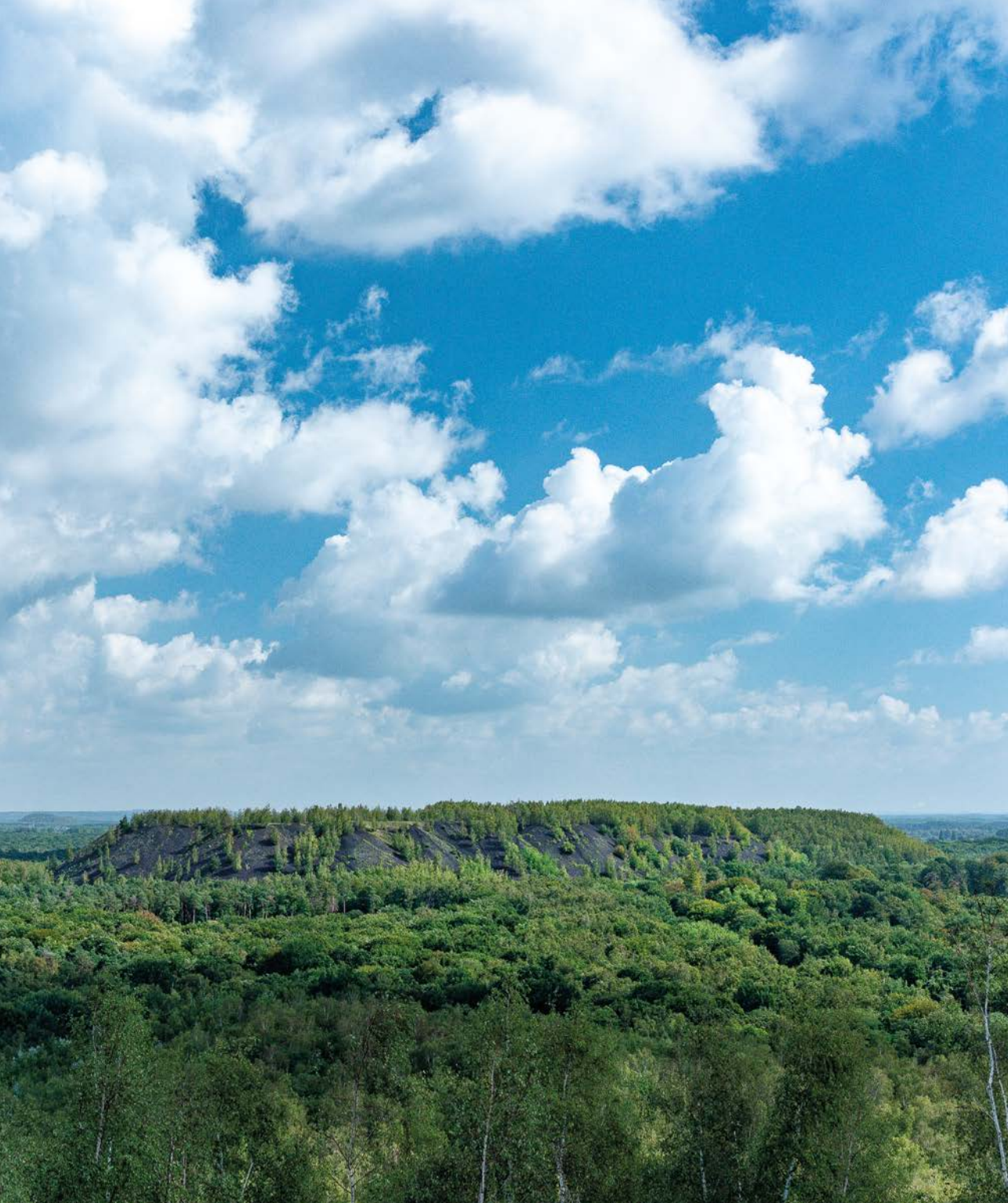
Vue sud-ouest, depuis le sommet du terril Sabatier nord, à Raismes. Le terril tabulaire allongé émerge au-dessus de la forêt domaniale de Raismes-Saint-Amand-Wallers. © DREAL HdF 2020 – F. Burjes
