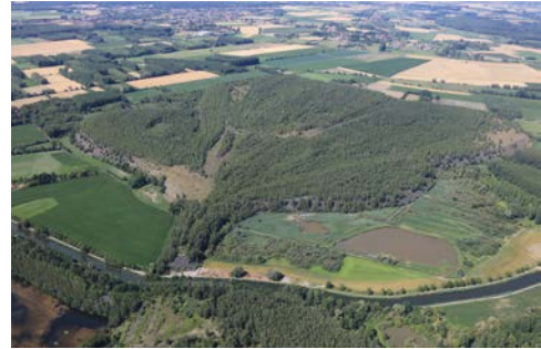
Vue aérienne vers le nord depuis Pecquencourt. Les courbes du terril et l'implantation des arbres reflètent l'avancement en éventail de la mise à terril par voie ferrée, l'excroissance marque l'arrivée de celle-ci. © DREAL HdF 2020 – Ph. Frutier.
