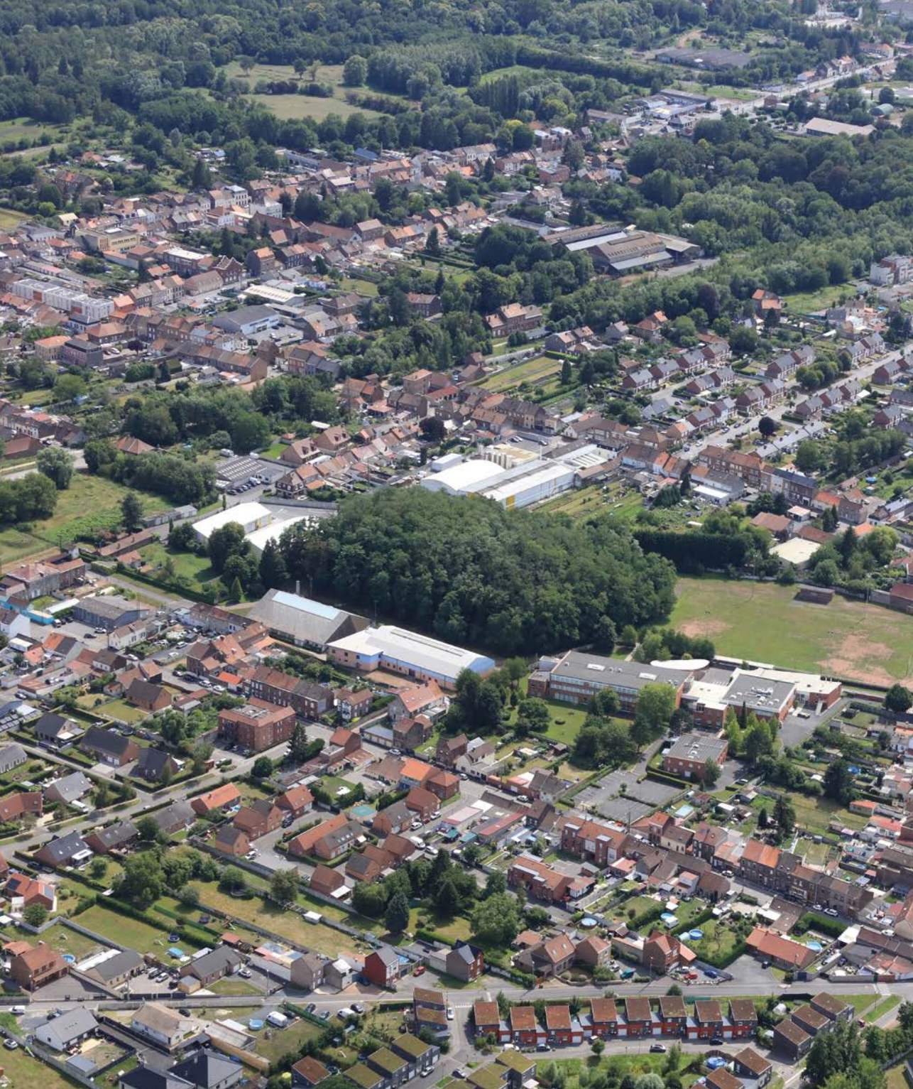
Vue aérienne vers le sud, depuis Fresnes-sur-Escaut. L'alignement d'arbres au sud du terril, marque le tracé de la voie verte des Gueules noires. © DREAL Hdf 2020 – Ph. Frutier
