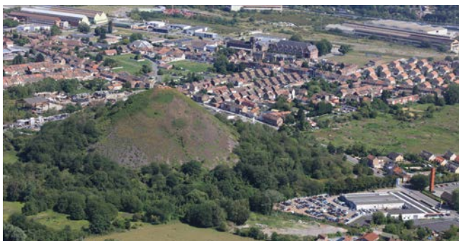
Vue aérienne vers le sud-est depuis Escaudain. Différentes strates de végétation et couleurs de schistes sont visibles. Au deuxième plan, des cités sidérurgiques.
