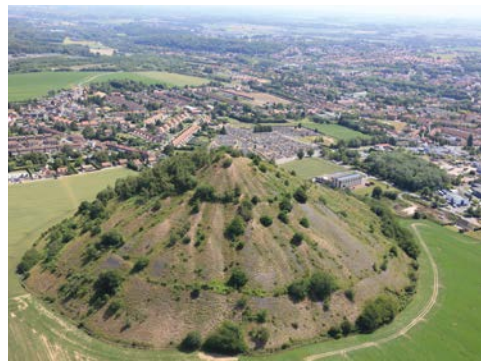
Vue aérienne vers l'est depuis Bruay-La-Buissière. En arrière-plan, les cités minières de Bruay-La-Buissière. © DREAL HdF 2020 – J.-M. André
