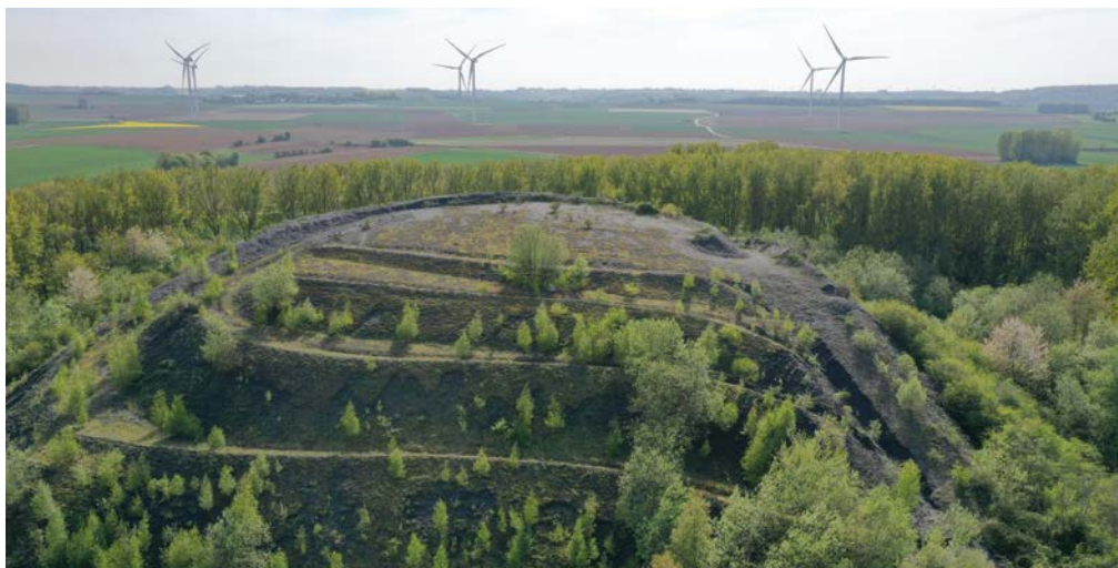
Vue aérienne vers le sud-ouest depuis le site à Ligny-lès-Aire. Vue sur les terrasses du terril 32. © DREAL Hdf 2020 – Ph. Frutier
