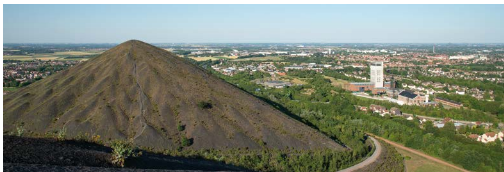
Vue sur les bosses en épis du T074, témoins de l'édification par rampe avec écoulement des matériaux dans des gouttières. © DREAL Hdf 2020 – J-M. André
