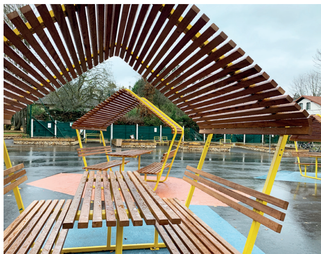
Installation de mobilier dans la cour - Collège Charles Lebrun - Montmorrency (95) © CAUE 95
