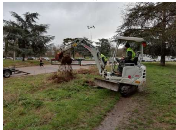
Dessouchage en bord de route (Bois de Boulogne) © VdP/Jean Schleiffer
