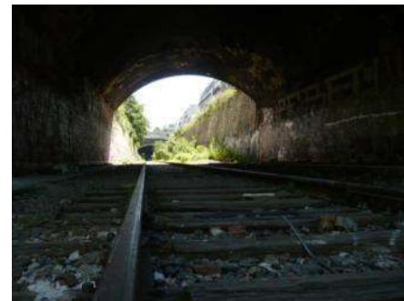
tunnel de la Petite Ceinture ferroviaire du 14 e arrondissement
