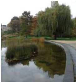
renaturation, par remplissage d'eau non potable et végétalisation en caisses, de l'ancien bassin-fontaine, initialement rempli d'eau traitée, au Parc Kellermann (13 e )
