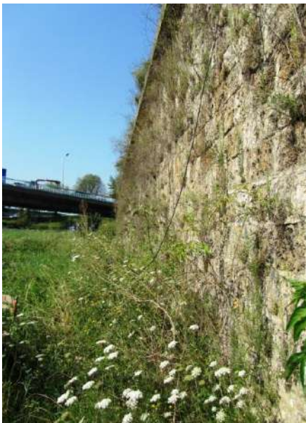
Mur avec interstices où plusieurs lézards ont été observés (Bastion - 12 e )
