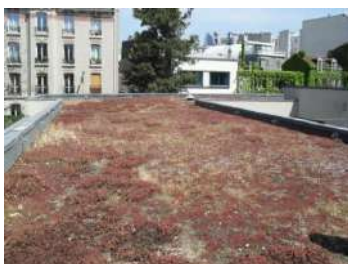
toiture végétalisée sur le toit des locaux sociaux du Père Lachaise (20 e )
