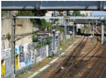
faisceau ferroviaire actif Gare du Nord, 10°
