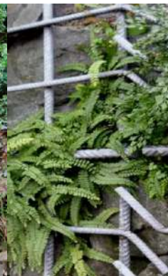
gabion le long d'un mur de soutènement, Quai François-Mauriac (13 e )
