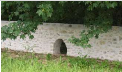
passage à faune à la base du mur d'enceinte du Domaine de Montauger / Maison de l'environnement du département de l'Essonne
