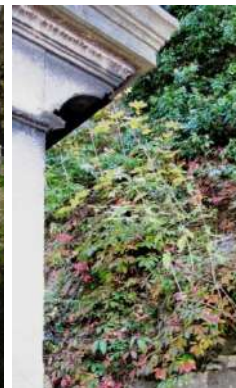
mur de soutènement couvert d'herbacées et grimpantes, Cimetièrre de Montmartre (18 e )
