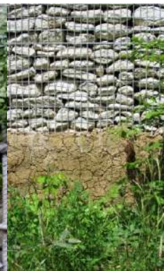
gabion, enduit de terre à la base, Forêt Linéaire Sud (19 e )
