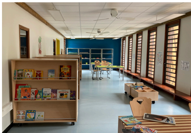
La bibliothèque: plafond acoustique, ventilation naturelle sur toute la façade et brasseurs d'air.
