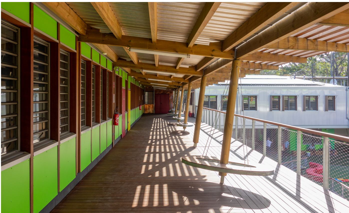
Les coursives avec leurs larges débords de toits protégeant du soleil comme de la pluie, et les bancs intégrés aux poteaux.
