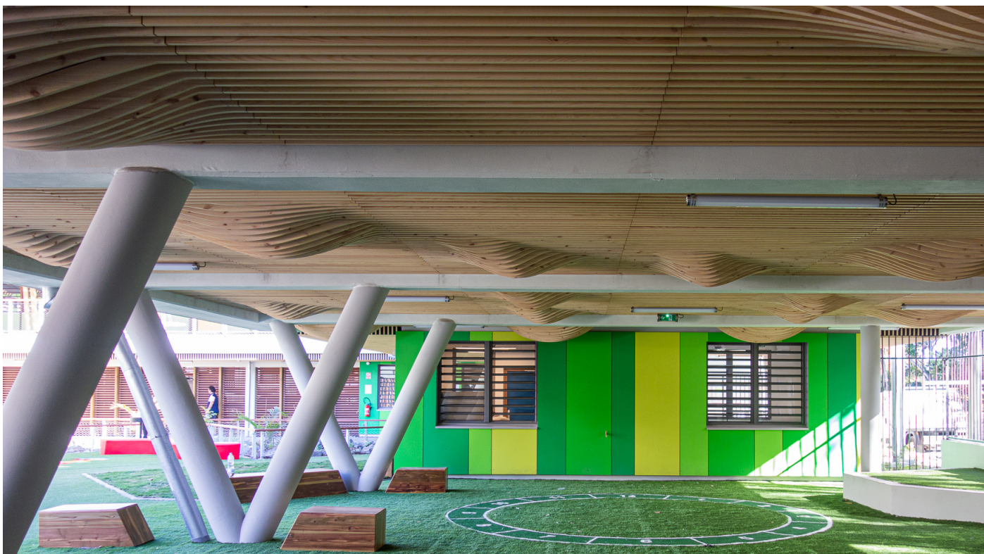
Le préau ouvert sur la cour d'école, disposé sous le plateau sportif, avec son plafond acoustique
