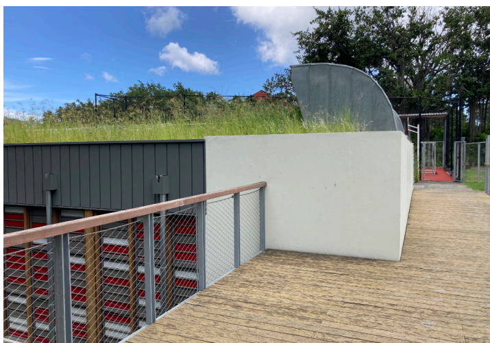
Vue de la toiture végétalisée de la salle polyvalente avec ses écopes.
