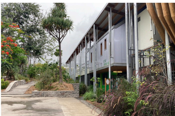
Zones plantées en périphérie des bâtiments et impluvium formant zones de rétention EP à l'intérieur de la cour d'école.
