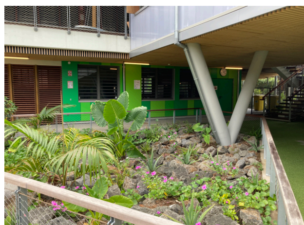
Zones plantées en périphérie des bâtiments et impluvium formant zones de rétention EP à l'intérieur de la cour d'école.
