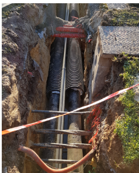
Réseau primaire dans une tranchée
