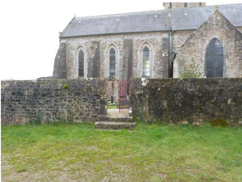
Clôture d'assemblage de panneaux de ciment armé bloqués Ci-dessous partie du mur ancien en appareil de moellons en pierre de pays
