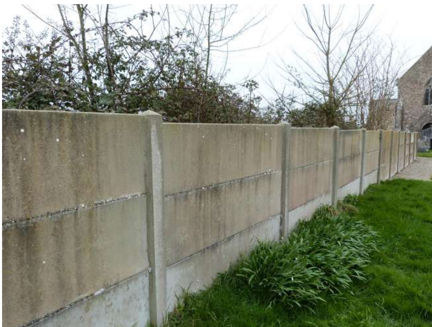
Clôture d'assemblage de panneaux de ciment armé bloqués Ci-dessous partie du mur ancien en appareil de moellons en pierre de pays
