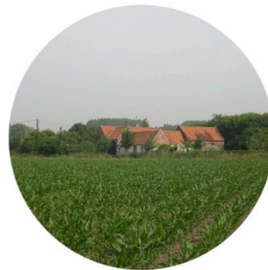
Réhabilitation de la ferme Lansau, Marchiennes
