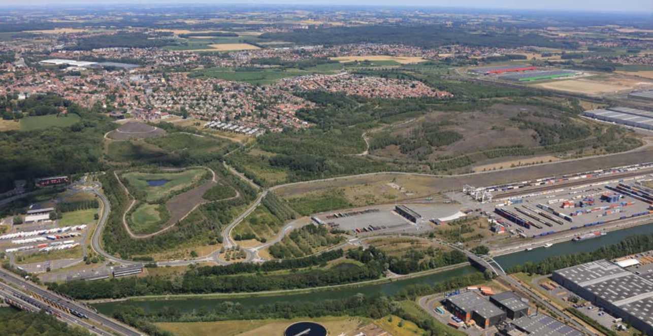
Vue aérienne vers le nord-est du site du 9-9bis à Oignies depuis Dourges. De gauche à droite, le terril 110, avec son chemin en colimaçon, les bassins de décantation et la fosse. Au premier plan, la plate-forme d'échange multimodale « Delta 3 », le canal de la Deûle et l'autoroute. En troisième-plan, la commune de Oignies et ces cités minières. © DREAL HdF 2020 – Ph. Frutier
