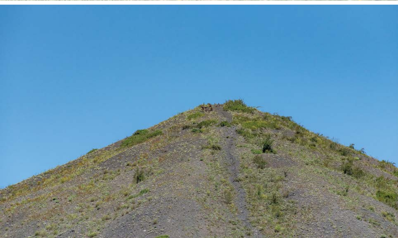
En haut : vue est depuis Billy-Montigny. Ce profil montre à gauche la pente de la rampe de chargement, et à droite la bosse témoin de la première mise à terril. © DREAL HdF 2020 – F. Burjes En bas : vue sur le sommet du terril et les restes des traverses de la rampe de chargement. © DREAL HdF 2020 – F. Burjes
