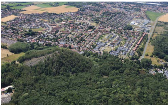
Vue aérienne vers l'ouest depuis Ostricourt. Au premier plan le Bois d'Offlarde avec le terril en lisière. Au deuxième plan, les cités minières d'Ostricourt, © DREAL Hdf 2020 – Ph. Frutier
