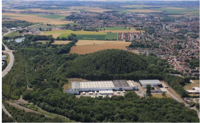
Vue aérienne vers l'ouest depuis Libercourt. Le terril est accompagné d'un boisement contraint par les infrastructures. À droite, la commune de Carvin. En arrière-plan, le terril d'Estevelle est visible au cœur de l'espace agricole. © DREAL HdF 2020 – Ph. Frutier
