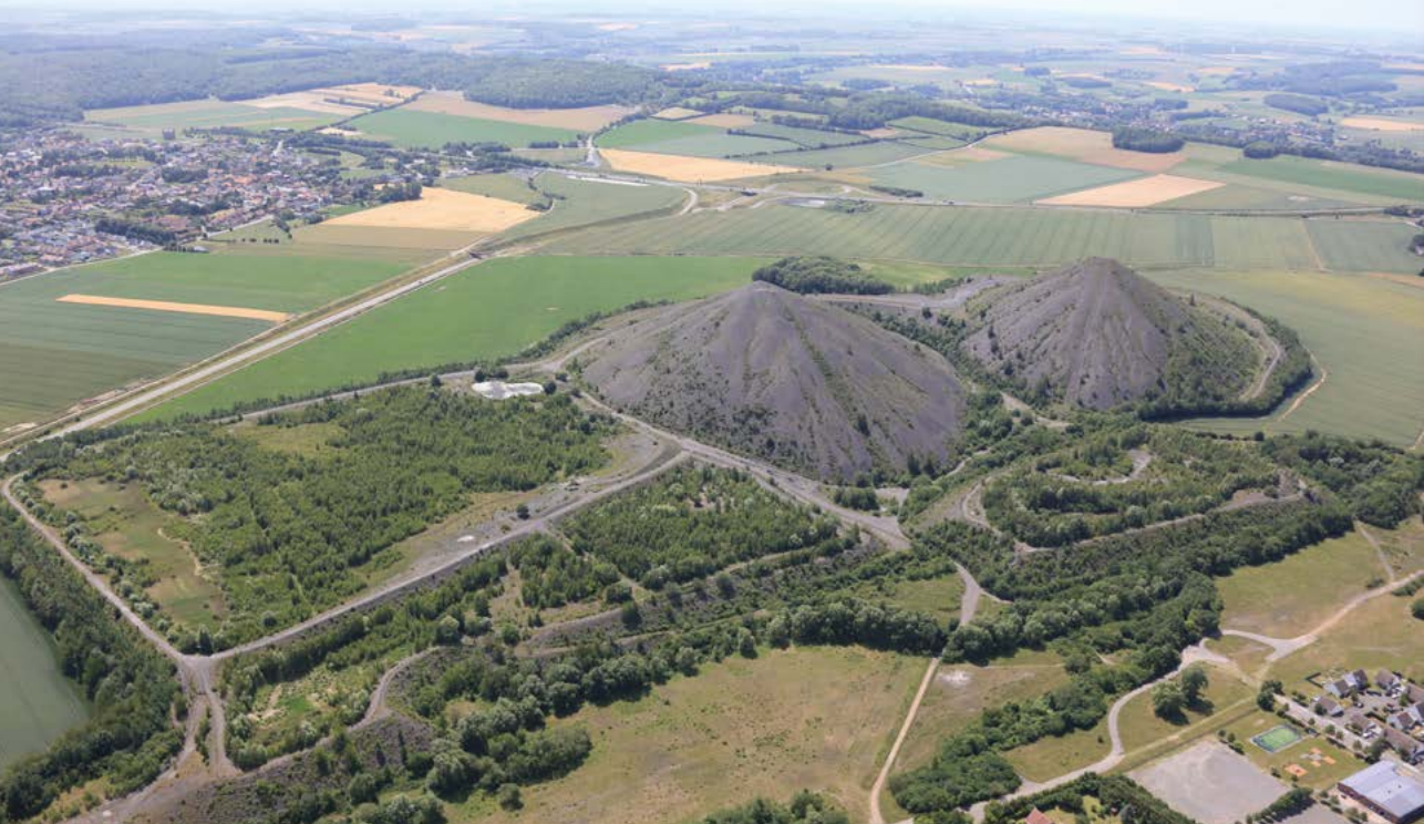
Vue aérienne vers le sud depuis Haillicourt. Au premier-plan à droite, l'ancien carreau de fosse aménagé en espace vert. À gauche des terrils, le bac à schlamm formant la plateforme. Vue sur les empreintes des rampes de chargement de chacun des terrils. En arrière-plan les collines de l'Artois et la forêt Domaniale d'Olhain. © DREAL HdF 2020 – Ph. Frutier
