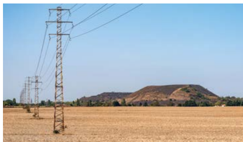
Vue sud-est sur les terrills 205 et 101 depuis un espace agricole à Hénin-Beaumont. © DREAL Hdf 2020 – F. Burjes
