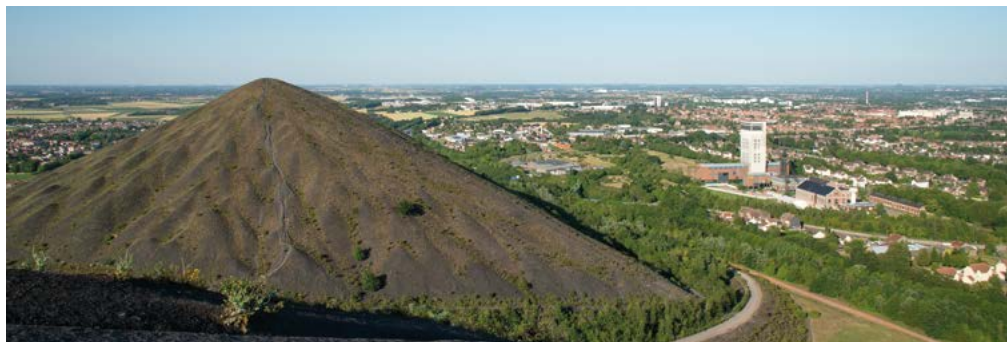
Vue sur les bosses en épaves du T074, témoins de l'édification par rampe avec écoulement des matériaux dans des gouttières. © DREAL Hdf 2020 – J-M. André
