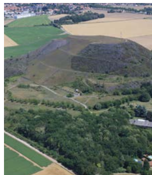
Vue aérienne vers l'est depuis Estevelles. Vue sur la « coulée verte » qui s'étend sur le carreau de fosse et à sa droite le chemin des mineurs. © DREAL HdF 2020 – Ph. Frutier
