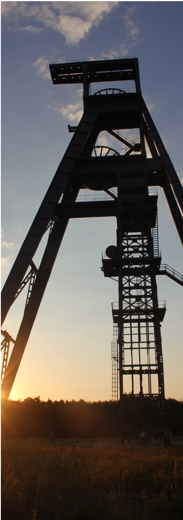
Chevalement Ledoux, Condé-sur-l'Escaut ©Mission Bassin Minier
