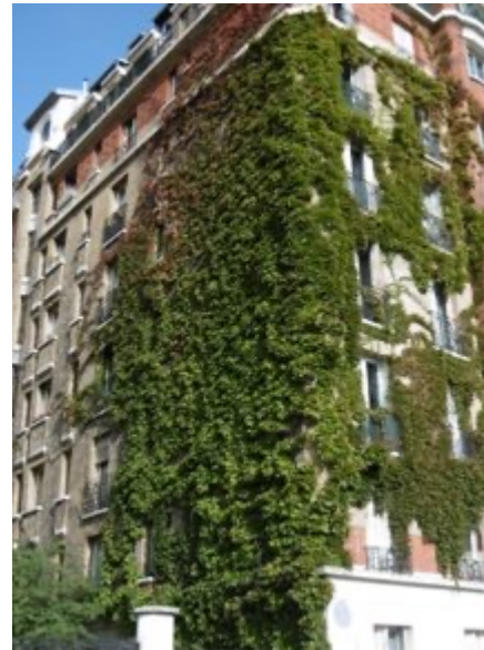
VÉGÉTALISATION DU BÂTI
