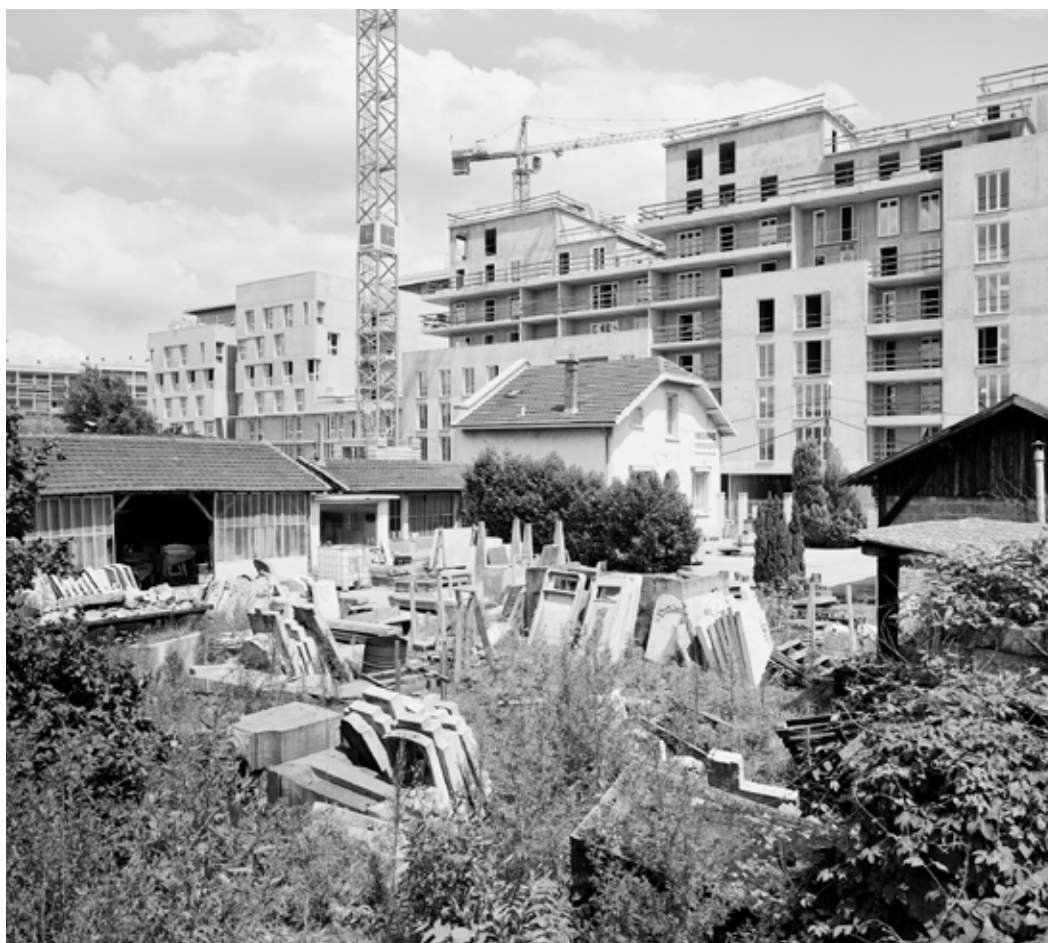
Ateliers taille de pierre, gravure et ciment, logement patronal, dépôt de stèles et ornements de la marbrerie Moine, 8 rue de l'Éternité à Lyon (Rhône). État en 2007 avant destruction.
