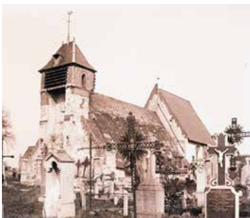
L'église de Vers-sur-Selles (Somme) et son cimetière. Vues en 1930 (Archives communales et communautaires d'Amiens métropole 12 Z 35) et en 2007.
