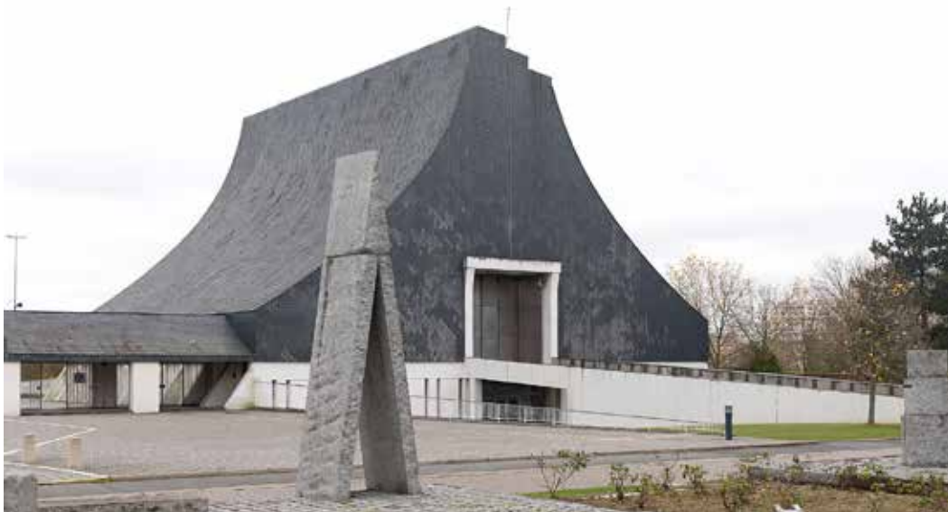
Funérarium du cimetière intercommunal de Valenton (Val-de-Marne).
