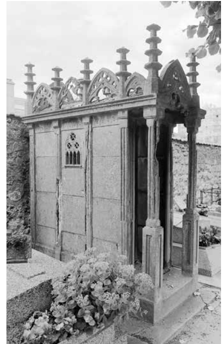
Chapelle funéraire néogothique en béton armé, des familles Guise et Foussignère, cimetière de Villejuif (Val-de-Marne).
