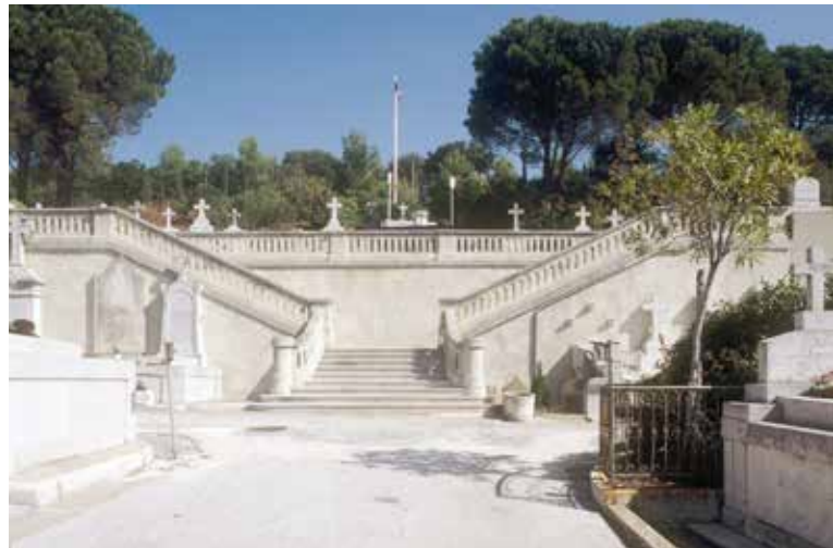
Escalier monumental donnant accès à la partie nord-ouest du cimetière de la Ritorte, Hyères (Var) dont la plaine d'inhumation forme ainsi un balcon sur le reste du site.
