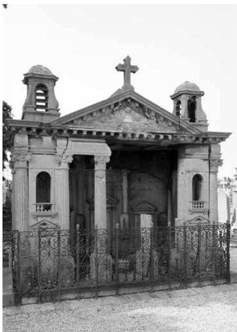
Monument funéraire de Virginie Antoinette Vantoortelboom, dite Reine des anges, cimetière de Dunkerque (Nord). Il s'agit d'une réplique, en réduction, du péristyle de l'église Saint-Éloi de Dunkerque, détruite en 1884.
