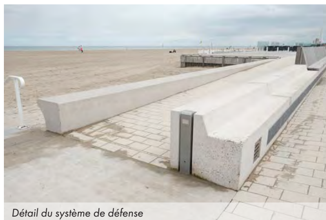
Ouvrage de protection sur la Digue des Alliés, Malo-les-Bains
