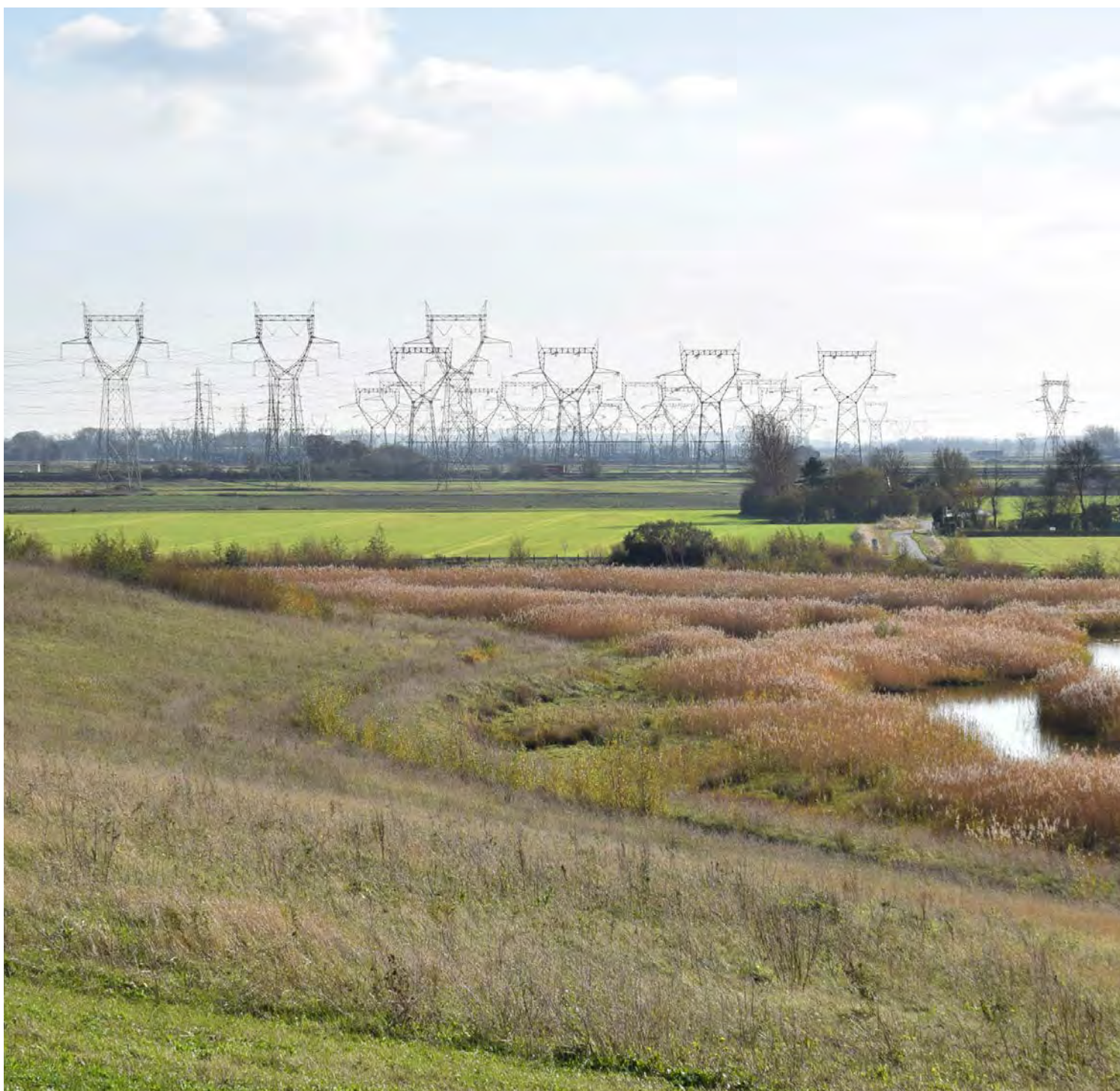
Pylônes électriques de la centrale de Gravelines depuis le PArc des rives de l'Aa
