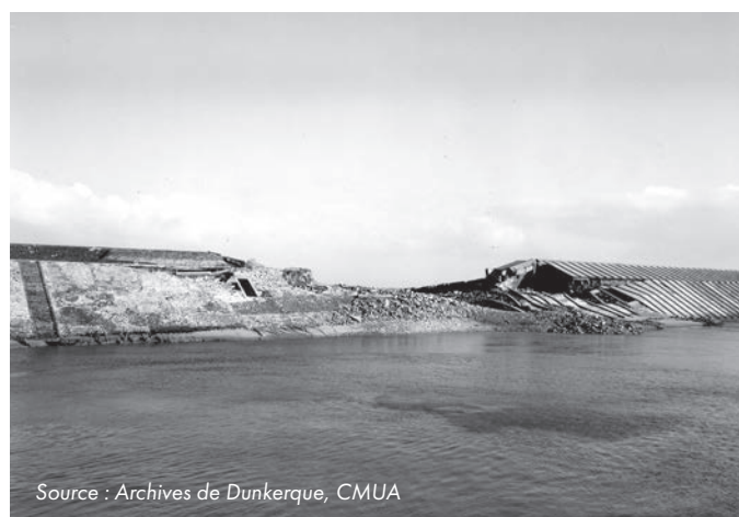
Brèche sur la digue du Canal Exutoire, inondations de 1953
