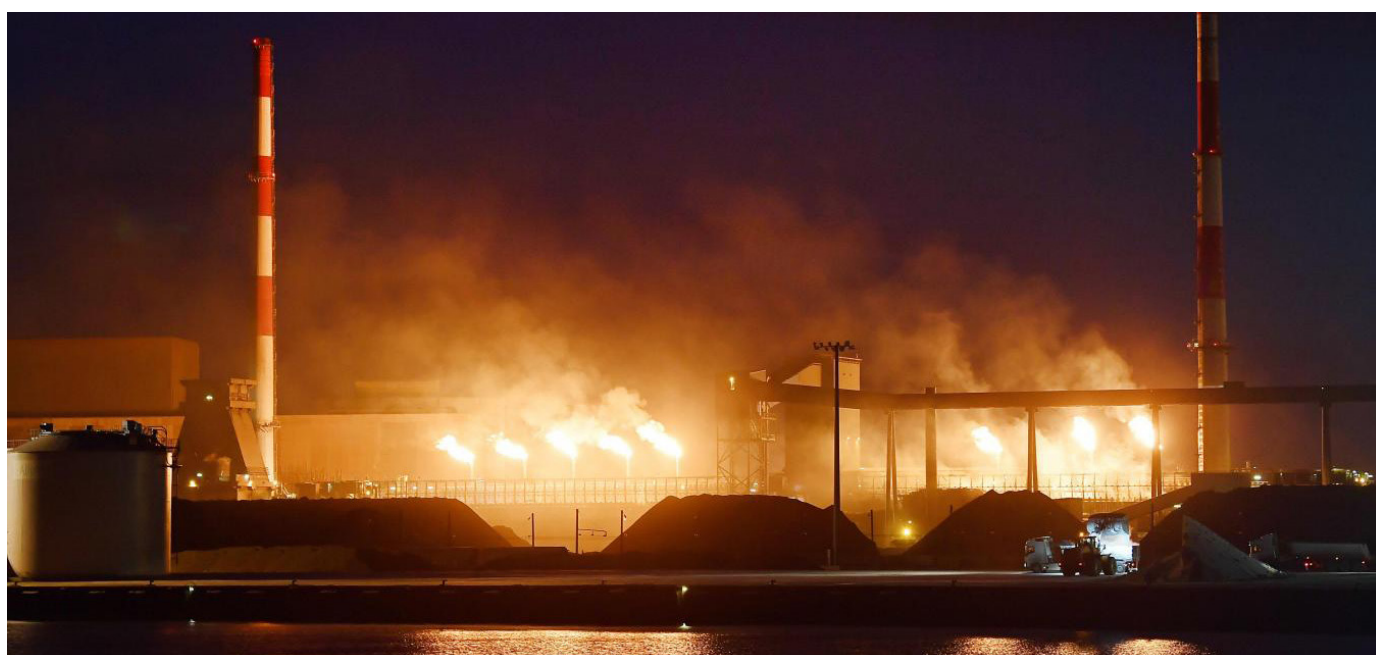
Une explosion à l'usine ArcelorMittal en novembre 2020
