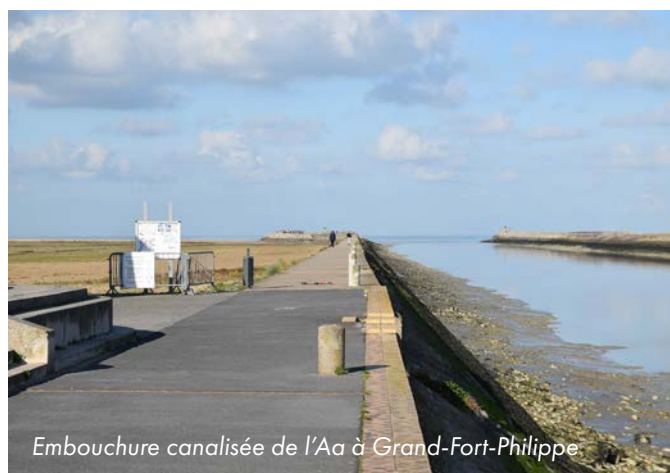
Ouvrage hydraulique permettant le contrôle du niveau d'eau sur la plaine wateringuée
