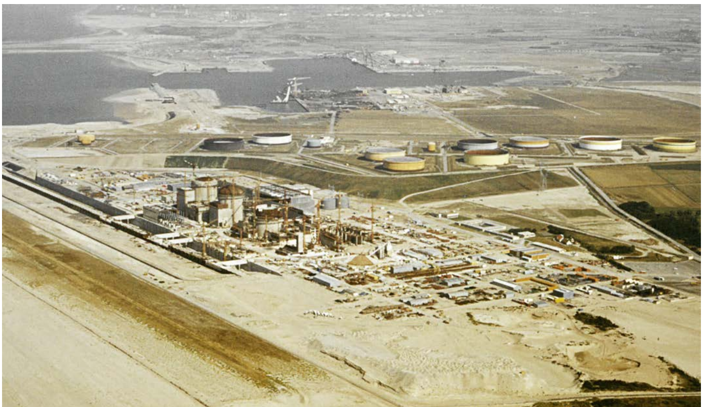
Construction de la centrale nucléaire à Gravelines, 1976
