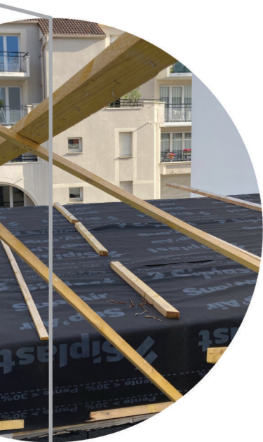
Étanchéité de la toiture
