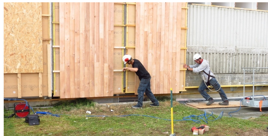
Travaux de rénovation
