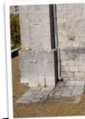
Des descentes de gouttières crachant en pied de murs fragilisent l'équilibre sanitaire des maçonneries...
