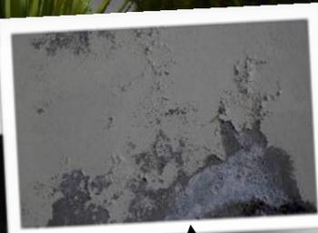
Par effet de mèche, l'humidité remonte dans les ouvrages bâtis. Les supports « fermés » réalisés au ciment bloquent toute possibilité de perspiration pour les murs.
