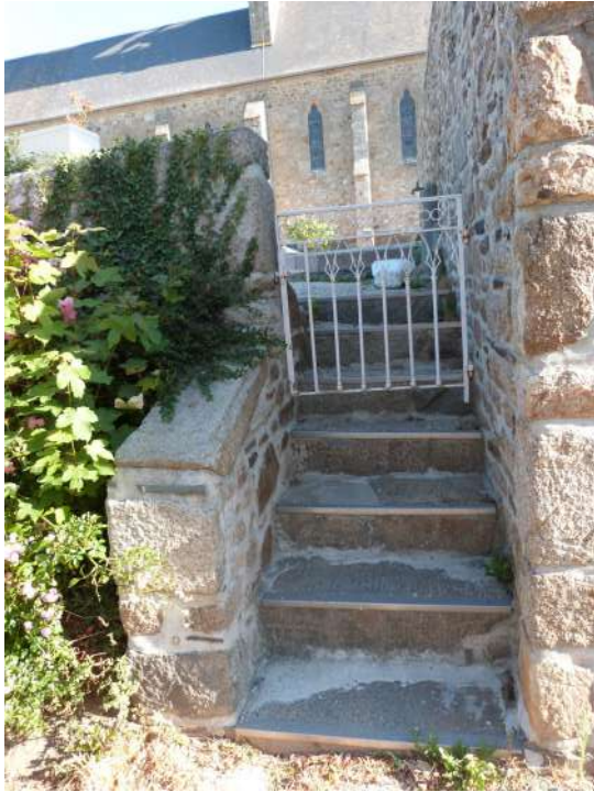
Accès piéton, portillon Accès contemporain pour véhicule de service.
