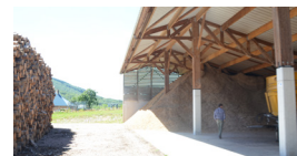
Hangar communal à Glux-en-Glenne
