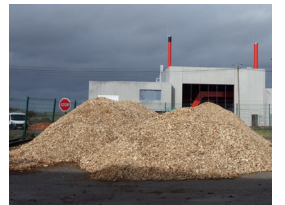
Copeaux de bois pour la chaufferie
