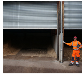
Hangar de stockage des plaquettes bois
