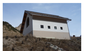
Le bâtiment de la microcentrale en entrée de village
