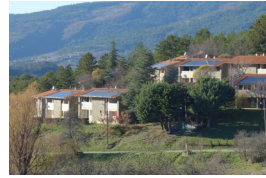
Les panneaux sur le toit des anciens gîtes de vacances
