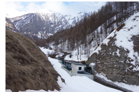
L'ouvrage de la prise d'eau
