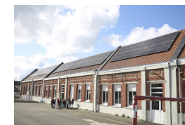
Ici, les toitures des bâtiments de l'école sont recouvertes de panneaux solaires sur la totalité, encadrées d'une bordure de tuiles. © P.Delance
