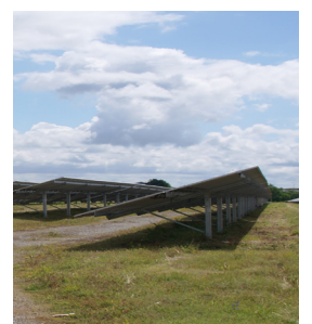
Parc photovoltaïque de Fontenay-le-Comte
