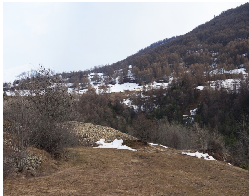
La conduite forcée enterrée sous les terrains agricoles
