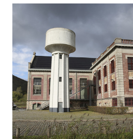
La base du 11/19 et sa toiture solaire sur un des bâtiments patrimonialisés. Le site est une propriété de la Communauté d'agglomération Lens-Liévin (CALL) qui teste, par le biais de son développement, le principe d'une zone d'activité dédiée. Choisir le développement durable comme concept fédérateur de l'ensemble des projets qu'accueille la Base 11/19 est un choix courageux de l'intercommunalité dont fait partie Loos-en-Gohelle. Elle est aidée en cela par l'implication forte des financeurs, en particulier le Conseil Régional Nord – Pas de Calais, l'État et les fonds européens. © P. Delance
