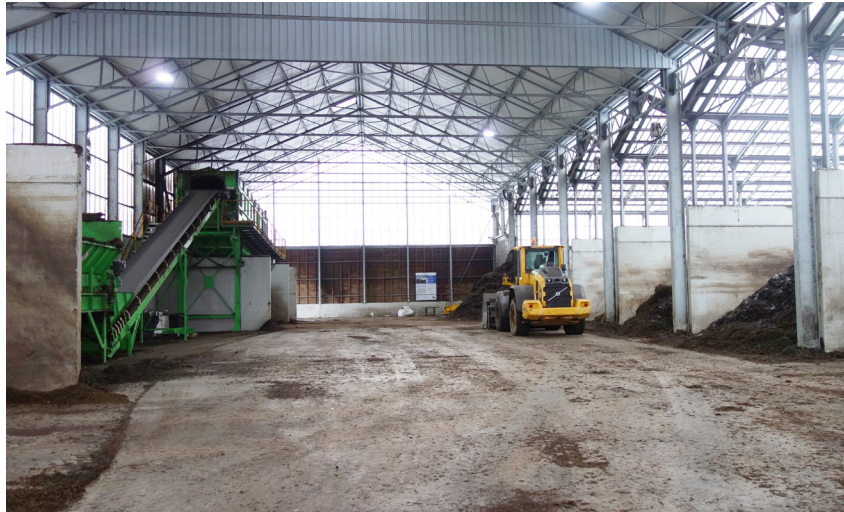
La gestion de la température des composts se fait sous des bâtiments couverts.
