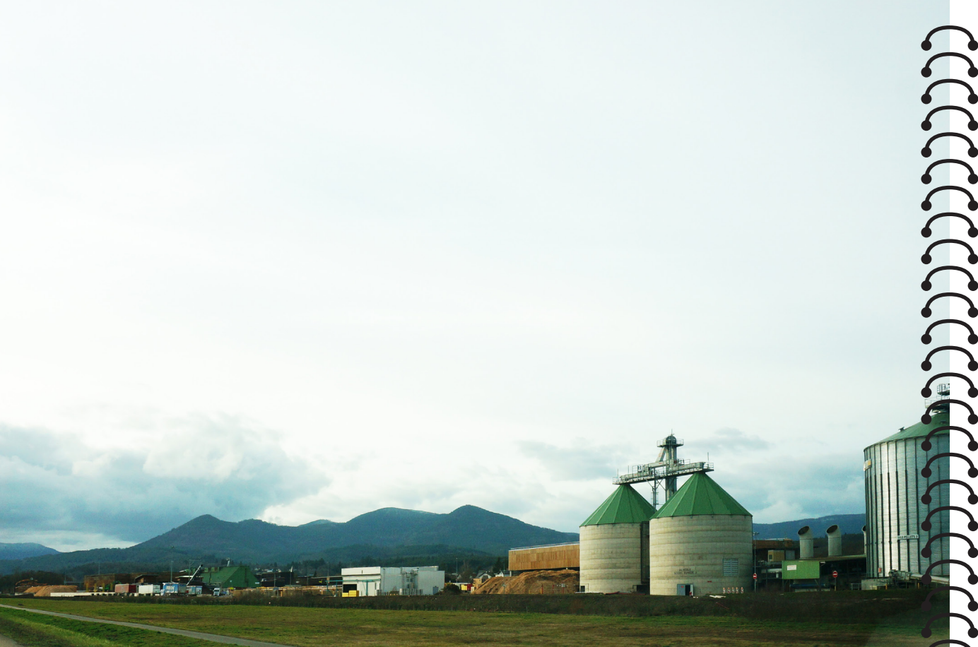
Les bâtiments de la scierie SIAT à l'entrée de la vallée de la Bruche
