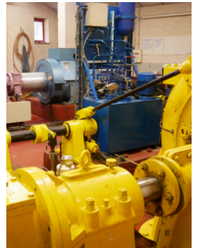
Chaudière à plaquette, Abbaye de la Pierre-qui-Vire.
