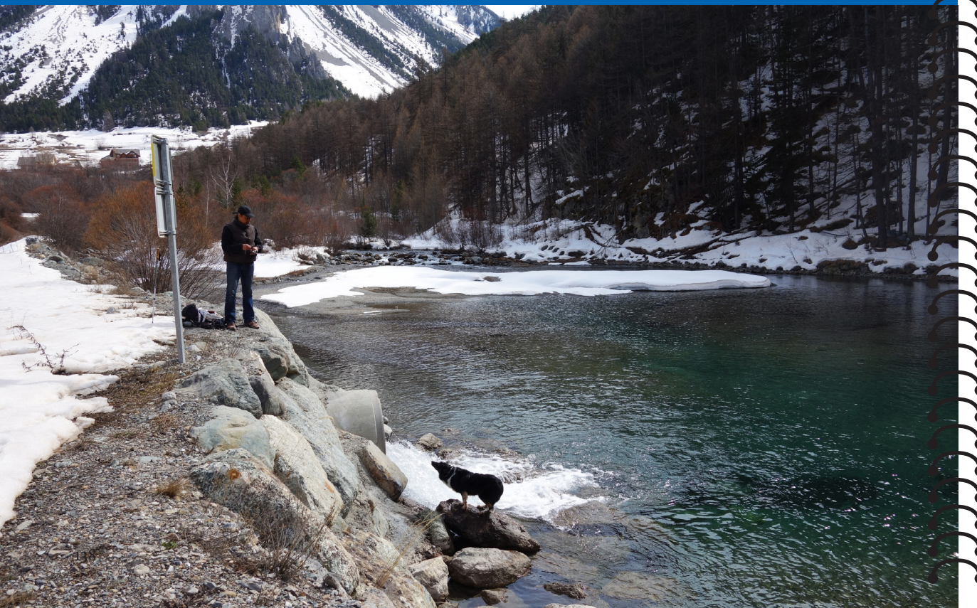
Prolongement du muret de soutènement existant
