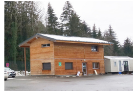
Bâtiment administratif conçu par un architecte spécialiste des chalets alpins
