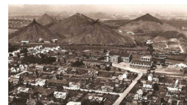
Puits n° 11 de la Compagnie des mines de Lens, Pas-de-Calais, France.
