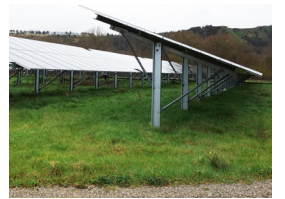
Surélévation des panneaux pour raison d'inondabilité
