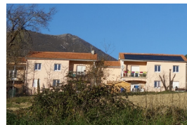
Les panneaux sur le toit de l'ancienne gendarmerie
