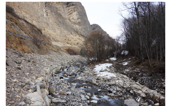
Mur de soutènement avec la pose en enterré de la canalisation entre le torrent et la route départementale
