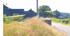
Bâtiment de la chaufferie communale de Glux-en-Glenne
