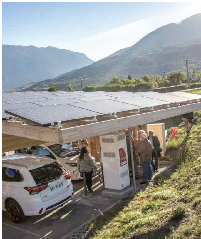
Ombrière photovoltaïque en autoconsommation de Baratier, Hautes-Alpes. SyMÉnergie05
