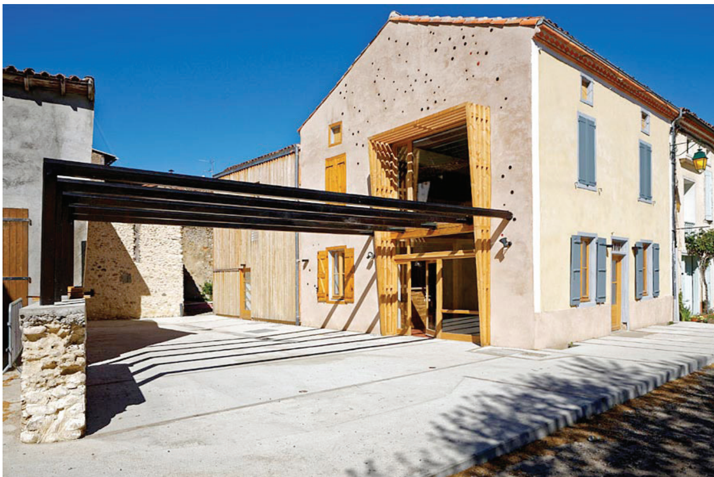
Bistrot de Pays L'Estanquet à Pailhès , Atelier Architecture et paysage : Rénovation d'un ancien bâtiment en faisant appel à du bois issu des alentours de la commune, pour en faire un bistrot de pays.
