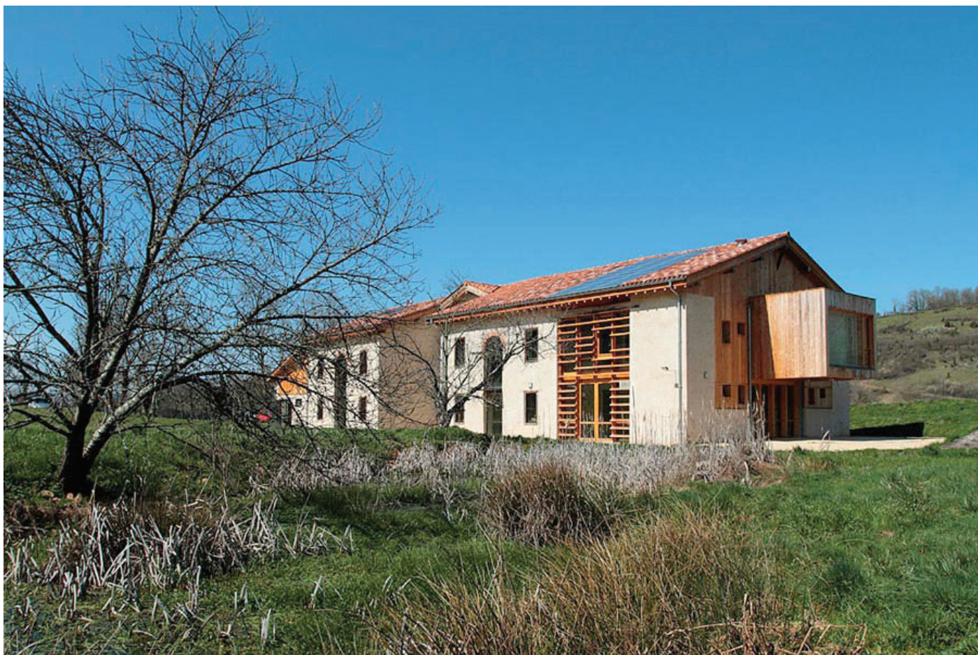
Ferme d'Icart à Montels , Atelier Architecture et paysage : Rénovation d'un ancien corps de ferme en faisant appel à différents bois et différentes pierres du territoire selon les usages et les espaces aménagés.
