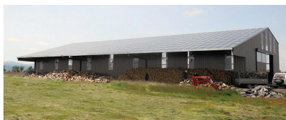
Toiture photovoltaïque en un seul pan continu
