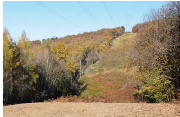
Ligne à Haute tension à Montégut-Plantaurel.
