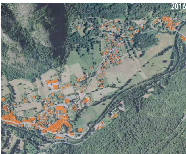
Vicdessos : la vallée entre Vicdessos et Arconac. L'habitat en noyaux compacts entourés de surfaces cultivées a laissé place à un mitage progressif des prairies par une urbanisation diffuse.
