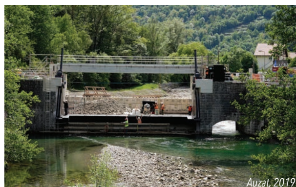
Les infrastructures hydroélectriques sont un patrimoine intéressant de la vallée, mais limitent l'usage des rivières
