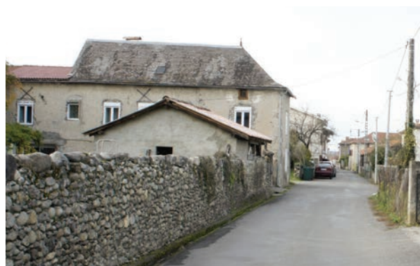
Difficultés de rénovation du bâti ancien
