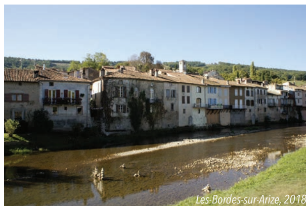
Façade fluviale de Bordes
