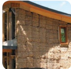
Construction en paille
