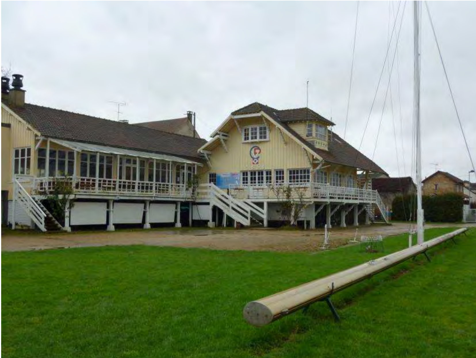
Le club house du cercle de la voile de Paris des Mureaux construit en 1894
