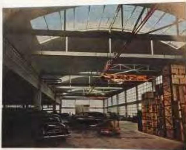
Vue intérieure des ateliers de montage et, en bas de page, coupe architecturale sur ces mêmes ateliers montrant la polychromie réalisée par Del Marle. Coupe: Défilé d'une travée des ateliers de montage. Réception, coupe et plan sur les axes constitués par des voûtes minces coulées sur des coffrages métalliques montés sur des échafaudages tubulaires roulants.
