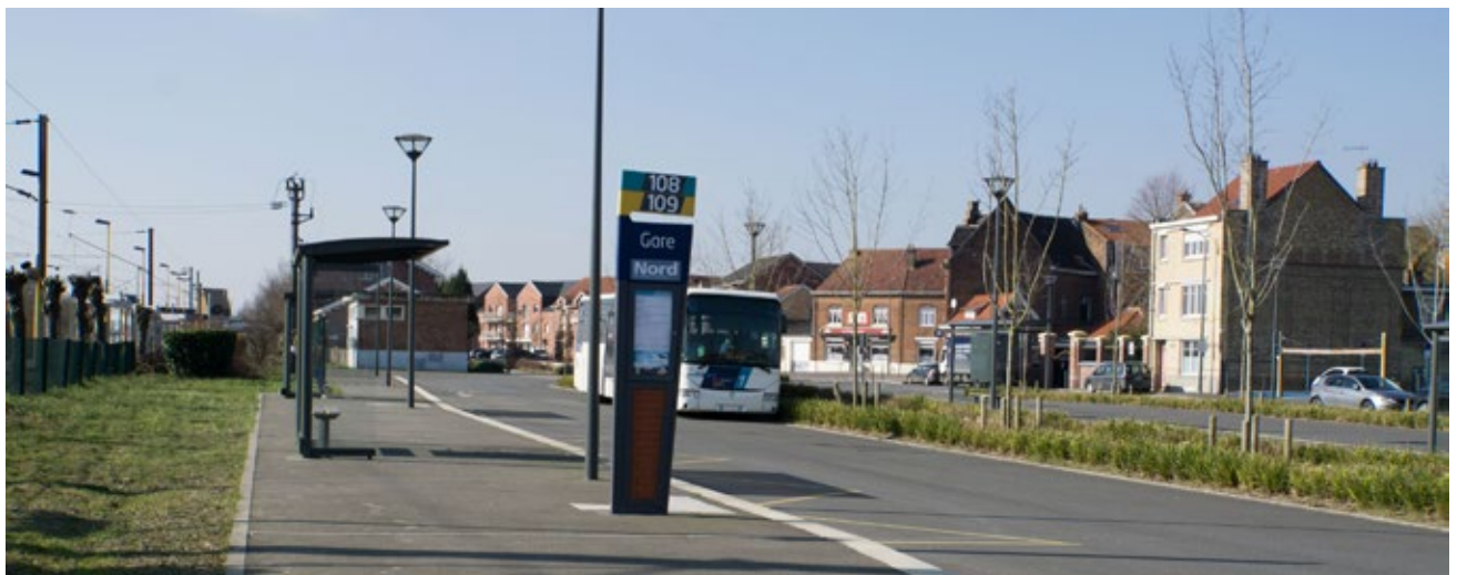
Gare de Bailleul / Station Bailleul © CCFI
