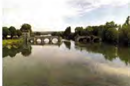
Vieux pont de Limay, photo Laurent Kruszyk
