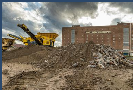
Economie circulaire sur les chantiers de déconstruction
