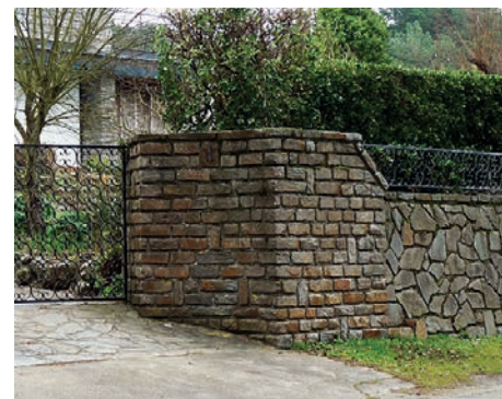
Clôture du XX e siècle avec moellons apparents, réguliers à l'angle, en opus incertum à droite.
