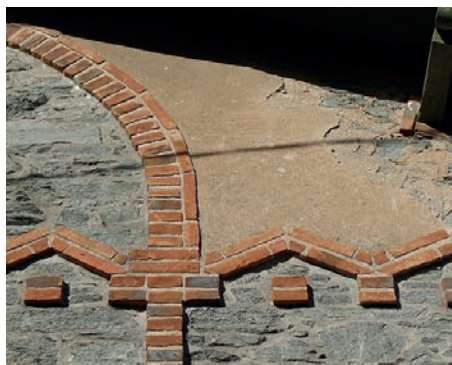
Jeu d'alternances de brique, d'enduit et de moellons apparents sur une villa du XIX e siècle.
