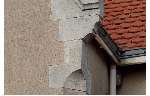
Enduit lissé réalisé au « nu » des pierres d'encadrements et d'arêtiers.
