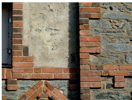
Façade de villa avec jeu d'alternance de parties enduites et de parties non enduites.
