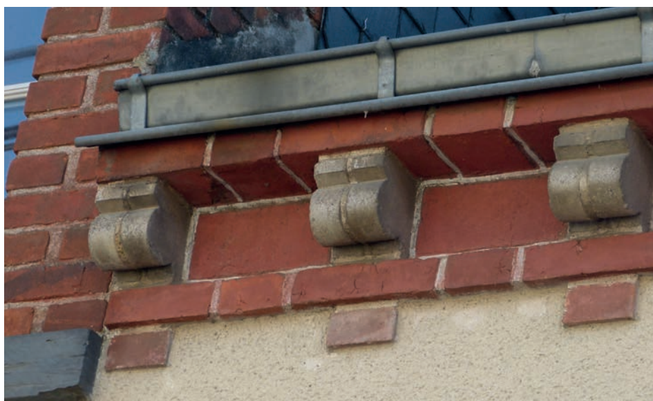
Cette façade d'une maison est restée dans son état du XIX e siècle. La toiture et les zingueries bien entretenues ont permis la conservation de la corniche en briques scellées au mortier de chaux, et de l'enduit d'origine composé de chaux et de sable.
