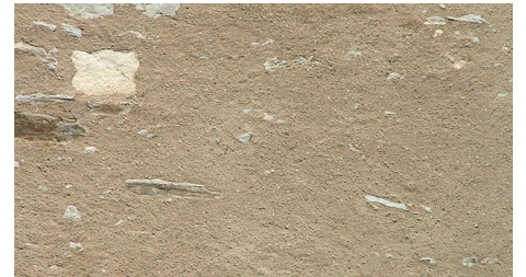
Enduit neuf « à pierres vues », possible sur des murs de clôture ou des bâtiments annexes.
