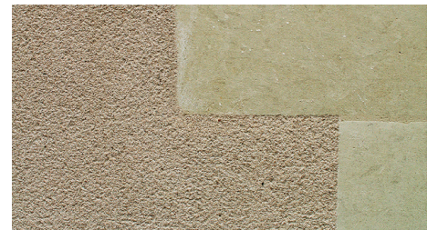
Enduit neuf lissé, réalisé au « nu » exact des pierres d'encadrement.
