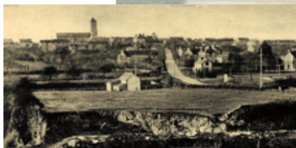
Carte postale ancienne présentant la carrière des fours à chaux Source : Archives de la Manche - www.archives-manche.fr
