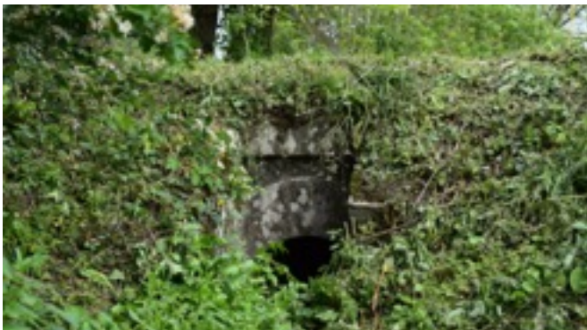
Ouvrage de franchissement du fossé du chemin rural dit rue Serenne par l'ancienne ligne de chemin de fer
