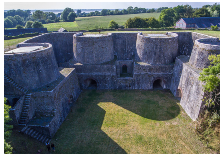
Les fours à chaux du Rey
