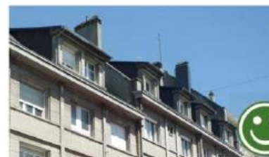
Lucarnes conservées dans leur état d'origine (maçonnerie enduite et jouées en ardoise). ▲
