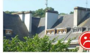
Lucarnes restaurées avec du bois verni qui ne se grisera pas. ▲
