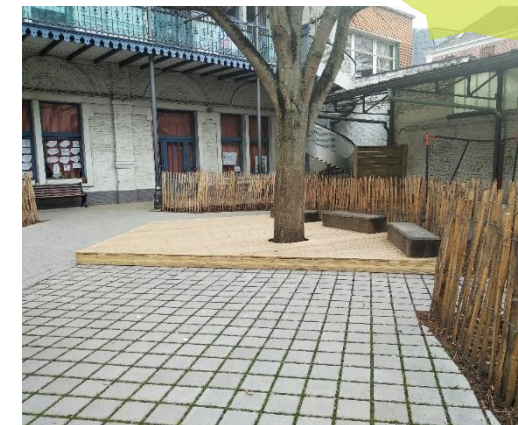
Pavés poreux non jointoyés, Lille
