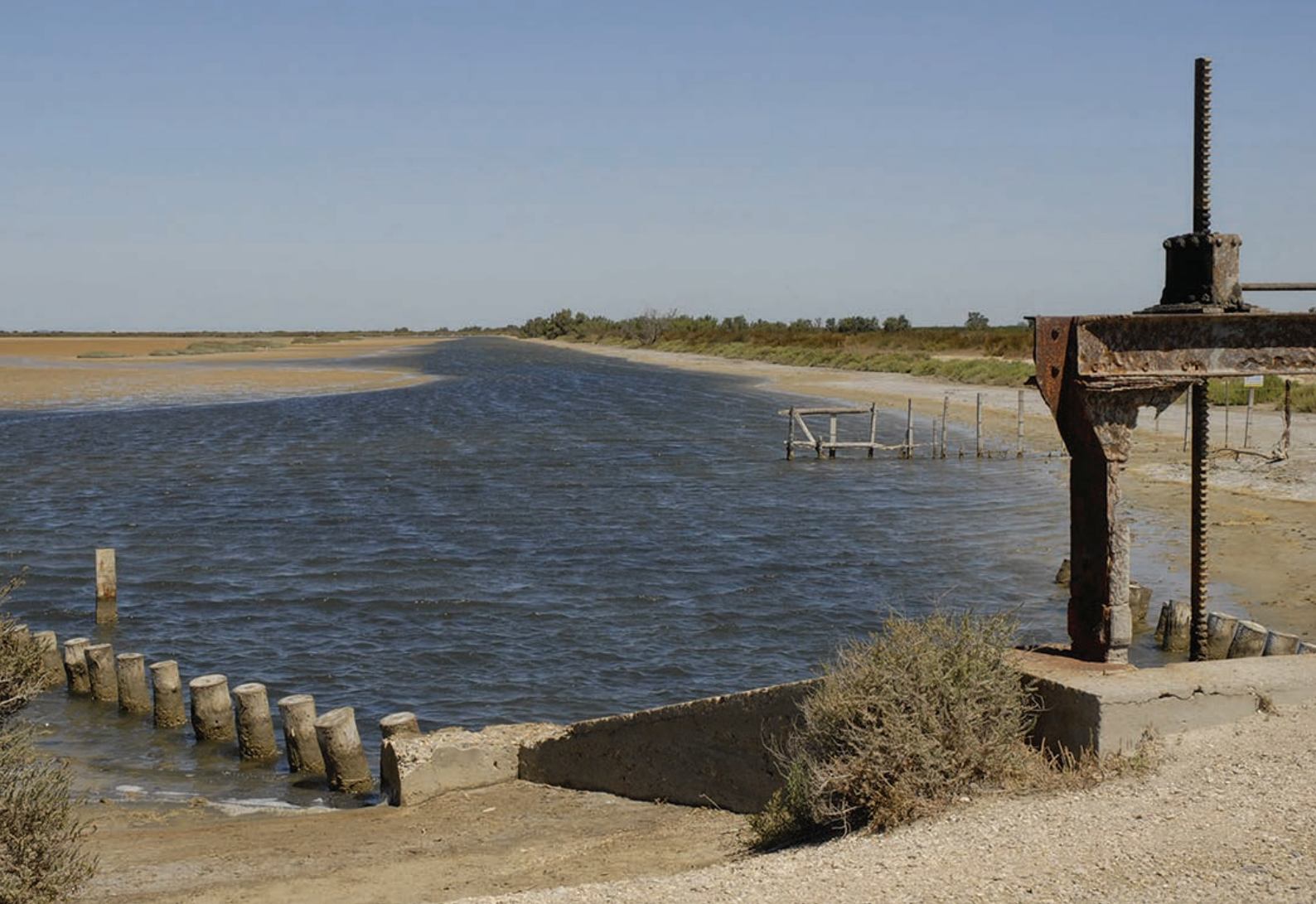
Observatoire Photographique du Parc naturel de Camargue : Digue d'Amphise aux salines (2009).
