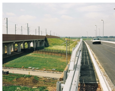
Itinéraire n°4, Nord-Pas-de-Calais (DREAL) © Dominique Auerbacher, OPNP. Seclin - TGV et D 925 passant sur voie ferrée et route en construction (04 003401), juin 1993.
