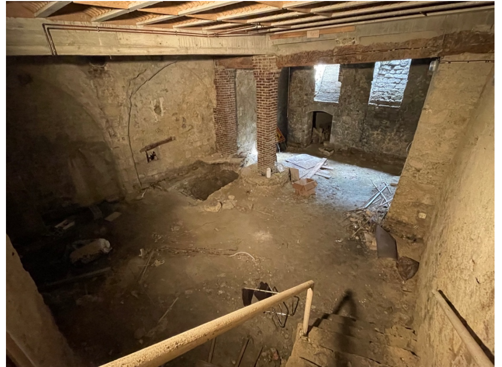
État existant – sous-sol (2022)
