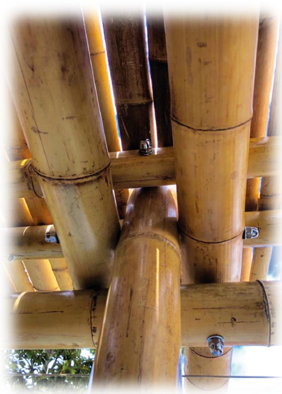
Notre pratique d'assemblage de structure, avec le MOSO, autre bambou légendaire largement utilisé en chine, présent à La Réunion, assemblage à la norme internationale ISO 22156 , <https://www.inbar.int/fr/iso-22156-2021/>
